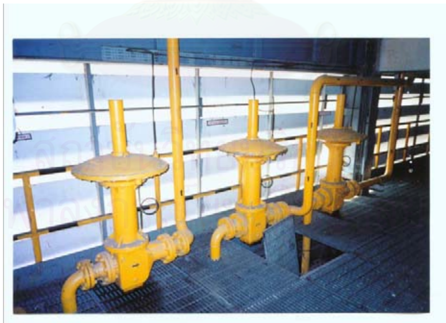
รูปที่ 6.10 อุปกรณ์ปรับความดันก๊าซบริเวณ Zone Regulator
