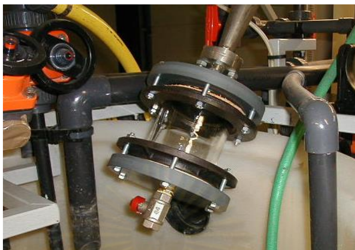
รูปที่ 3.7 การติดตั้งกริฟฟิตที่ช่องทางออกด้านล่างของไฮโดรไซโคลน
