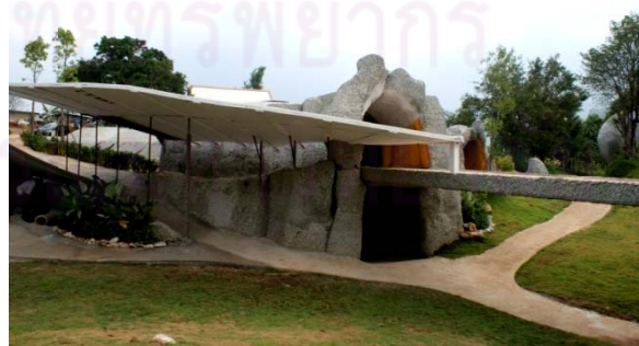
ภาพที่ 4-6 ความรูปลักษณ์ของห้องเรียนธรรมชาติที่แตกต่างจากอาคารทั่วไป ผนวกกับการปลูกพืชคลุมดินทำให้บริเวณทางเดินให้มีค่าการสะท้อนแสงต่ำ เมื่อมองแล้วเกิดความสบายตาจึงเป็นปัจจัยแรงกระตุ้นทางด้านสายตาทำให้คนอยากออกกำลังกายมากขึ้น
