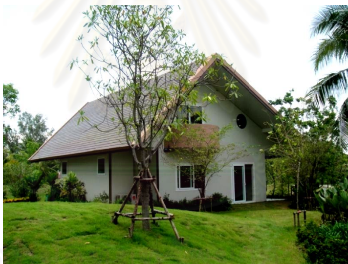
ภาพที่ 5-29 สภาพแวดล้อมบริเวณด้านหลังบ้านพอเพียงหลังปรับภูมิทัศน์ โดยใช้ต้นไม้ใหญ่สกัดกั้นการแผ่รังสีความร้อนจากดวงอาทิตย์และใช้ประโยชน์จากพืชคลุมดินดูดซับน้ำใต้ดินขึ้นมาระเหยและสร้างเนินดินเพื่อให้มีทัศนียภาพที่สวยงามทำให้คนเกิดแรงกระตุ้นและออกกำลังกายเพิ่มขึ้น
