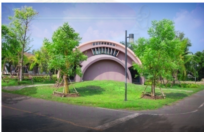
ภาพที่ 5-11 สภาพแวดล้อมบริเวณด้านหน้าห้องเรียนธรรมชาติหลังปรับปรุงทัศน โดยใช้ ต้นไม้ใหญ่สกัดกั้นการแผ่รังสีความร้อนจากดวงอาทิตย์และใช้ประโยชน์จาก พืชคลุมดินดูดซับน้ำใต้ดินขึ้นมาระเหยงทำให้อุณหภูมิอากาศบริเวณห้องเรียน ธรรมชาติเย็นลง
