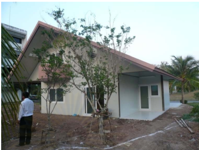
ภาพที่ 5-28 สภาพแวดล้อมบริเวณด้านหลังบ้านพอเพียงก่อนปรับภูมิทัศน์
