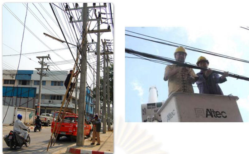
ภาพ ตัวอย่างลักษณะการวางสายเคเบิลที่ร่วมกับเสาไฟฟ้า
