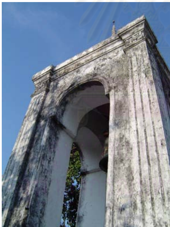
ภาพที่ 78 ลักษณะการเจาะร่องที่เสาอาคาร
