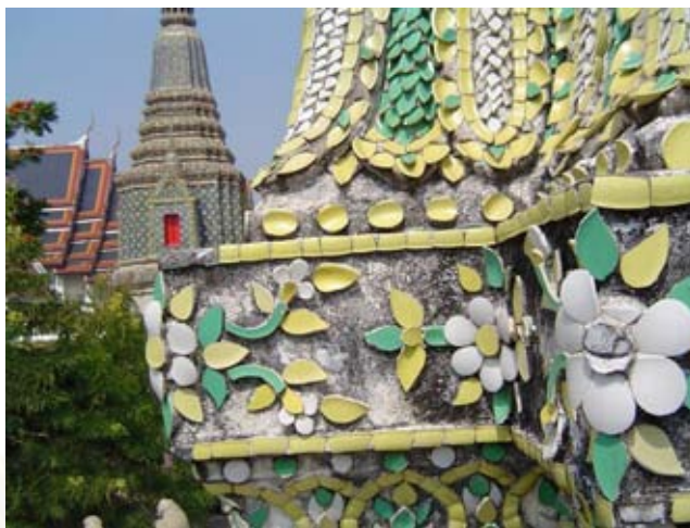
ภาพที่ 54 กระจเบื้องเคลือบสีตัดดอกประดับบริเวณฐานของส่วนเรือนหอรระฆัง
