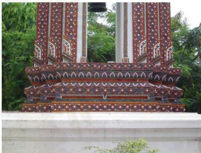
ภาพที่ 115 ฐานอาคารและฐานเรือนหอระฆังวัดเทพศิรินทราว
