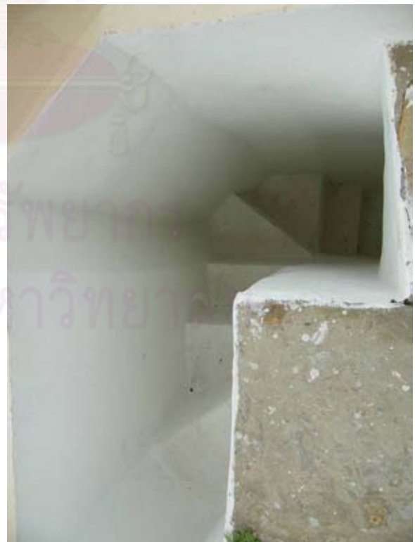
ภาพที่ 135 บันไดทางขึ้นสู่ชั้น 3
