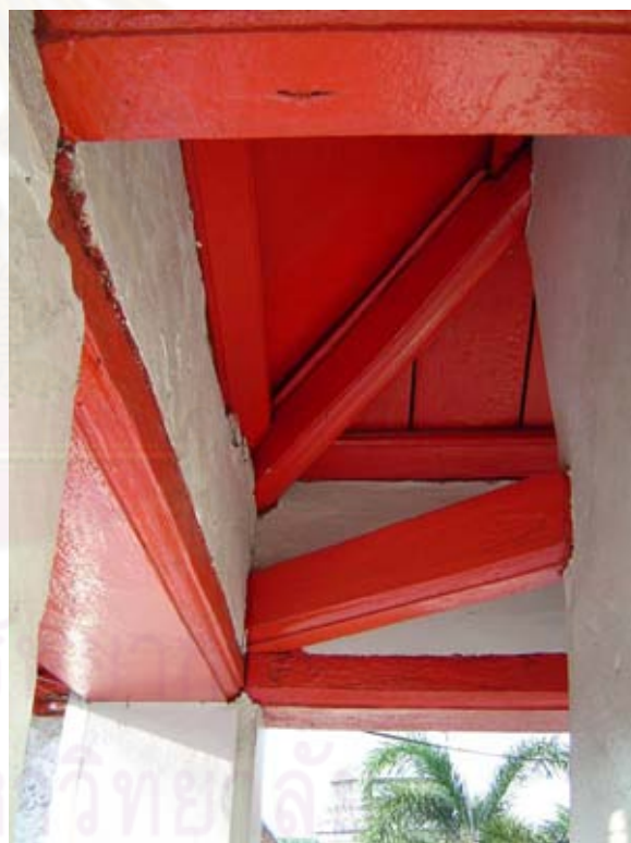
ภาพที่ 47 ฝ้าเพดานหลังคาชั้นสามของหอรระฆังวัดอรุณราชวราราม
