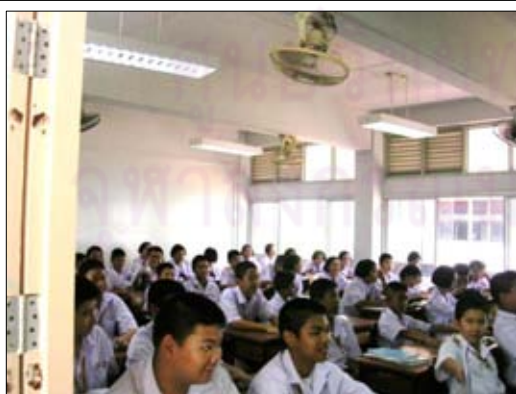
- ชุดหลอดฟลูออเรสเซนต์สำเร็จรูป ยึดที่ท้องพื้นในห้องเรียน
