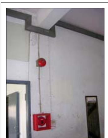
- ระบบเครื่องสัญญาณเตือนอัคคีภัย แบบมีอกตบริเวณอาคารเรียน
