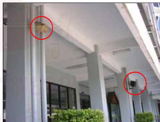
- ระบบเสียงเรียกประกาศ / PA ที่บริเวณระเบียงอาคาร
