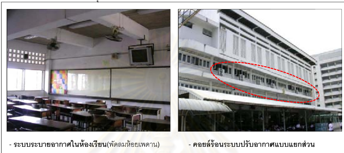
ภาพที่ 3.1.6 ระบบระบายอากาศ / ระบบปรับอากาศ
