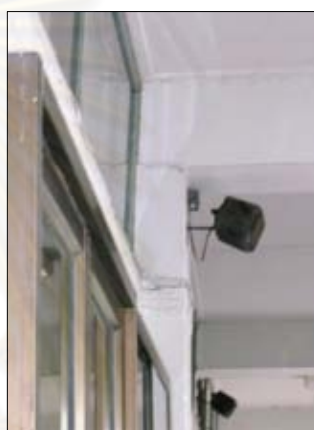
- เดินสายแบบเปลือยยึดแนบไปกับส่วนต่างๆ ของอาคาร
