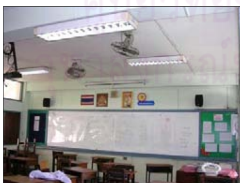
- ชุดหลอดฟลูออเรสเซนต์สำเร็จรูปยึดที่ท้องพื้นในห้องเรียน และที่บริเวณอื่นๆ
