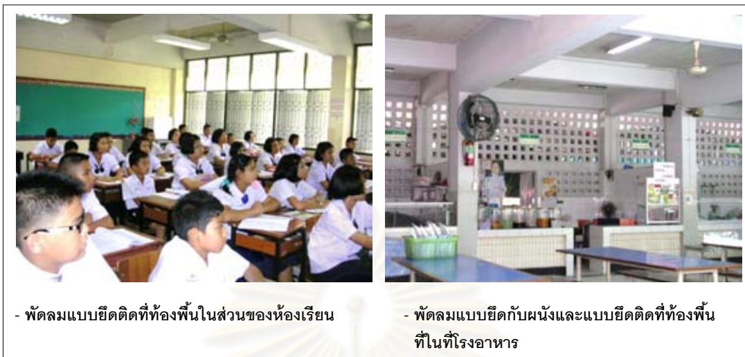
ภาพที่ 3.4.5 ระบบระบายอากาศ
