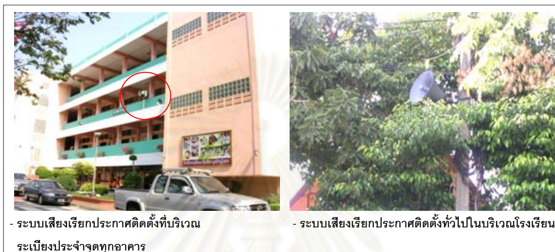
ภาพที่ 3.4.7 ระบบเสียงเรียกประกาศ / PA system
