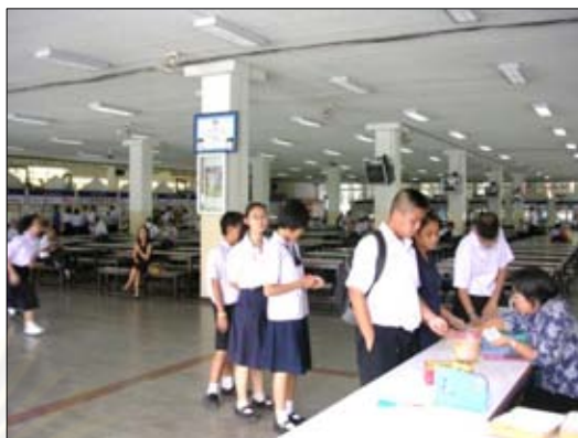
- พัดลมแบบห้อยเพดานในบริเวณโรงอาหาร
