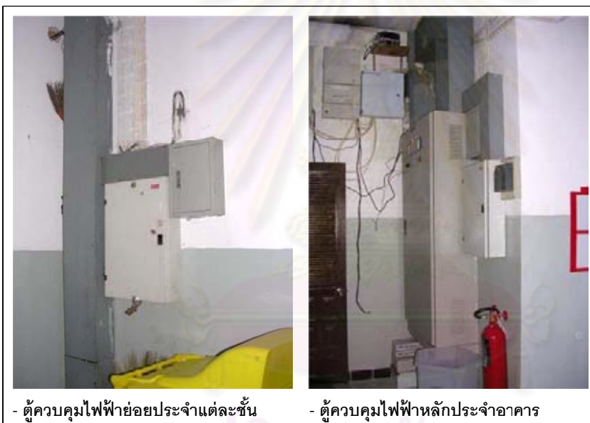
ภาพที่ 3.1.3 ระบบตู้ควบคุมไฟฟ้า
