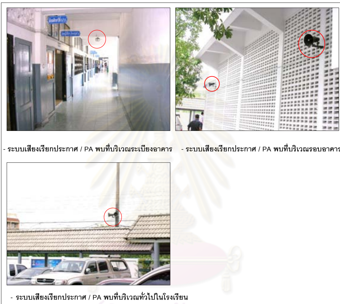
ภาพที่ 3.2.9 ระบบเสียงเรียกประกาศ / PA system
