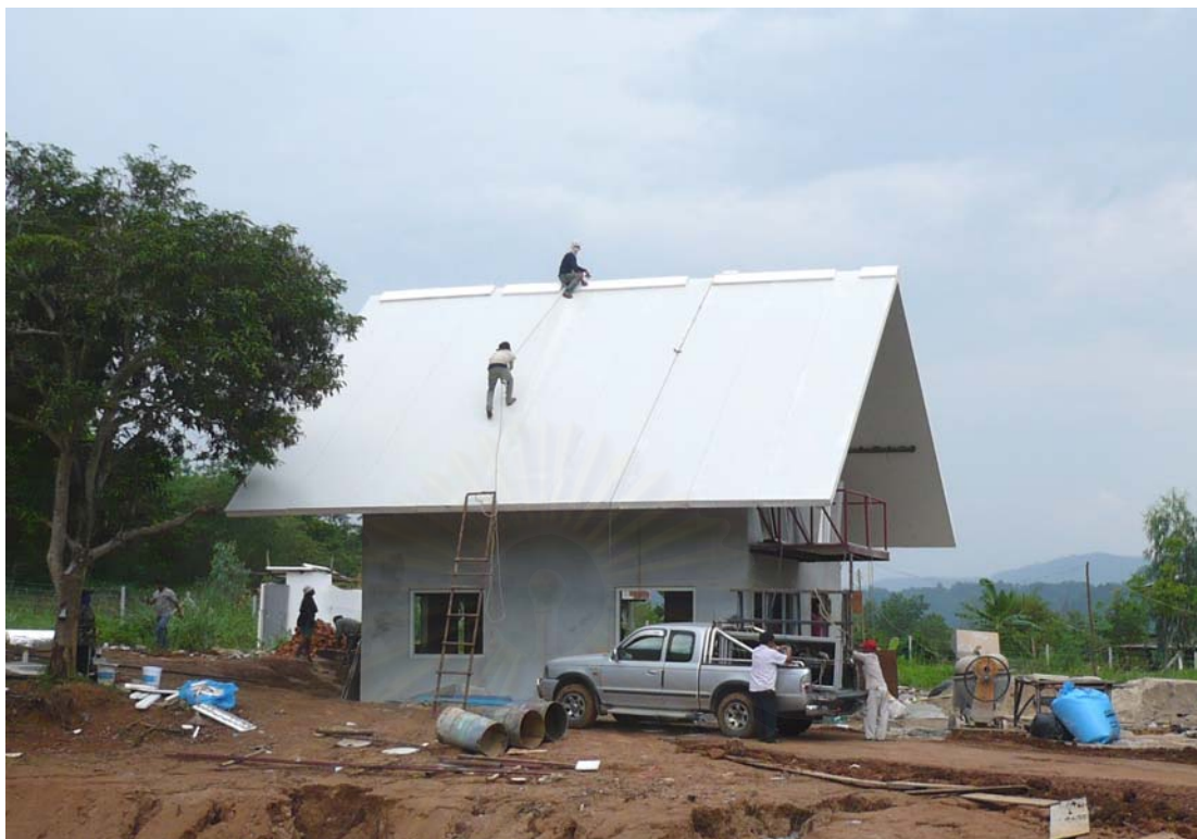
รูปที่ 5.3 แสดงบรรยากาศการก่อสร้างตัวอย่างภายนอกอาคารบ้านพักอาศัย 2 ชั้น ขนาด 100 ตารางเมตร ที่มีเปลือกอาคารเป็นวัสดุโพลีคอนกรีตหนา 0.20 เมตร (สถานที่ก่อสร้างในโครงการ อีโค-สเฟียร์ เขาใหญ่ จังหวัดนครราชสีมา วันที่ 4 พฤษภาคม 2551)
