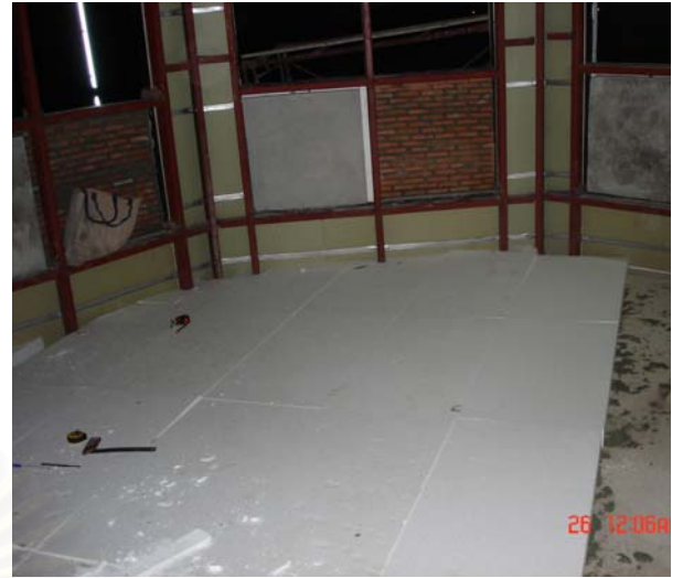
รูปที่ 3.13 แสดงการติดตั้งพื้นฉนวน EPS เพื่อป้องกันความร้อนจากพื้น
