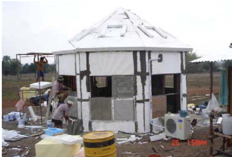
รูปที่ 3.7 การติดตั้งผนังทดลองทั้ง 4 ผนังโดยติดตั้งรอบอาคารทดลองทั้ง 8 ทิศ
