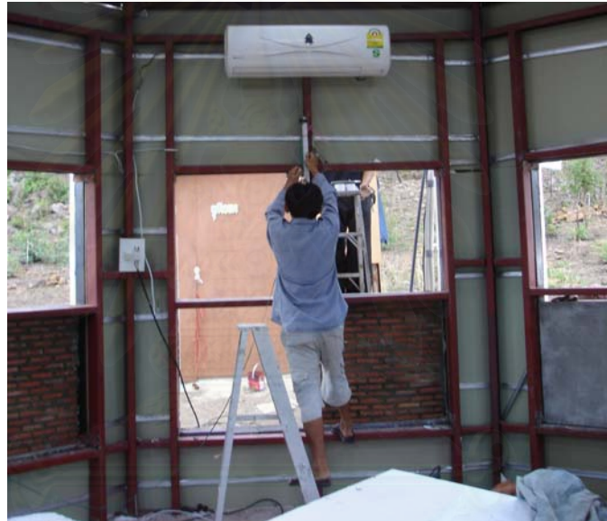
รูปที่ 3.14 แสดงการติดตั้งเครื่องปรับอากาศภายในห้องทดลอง
