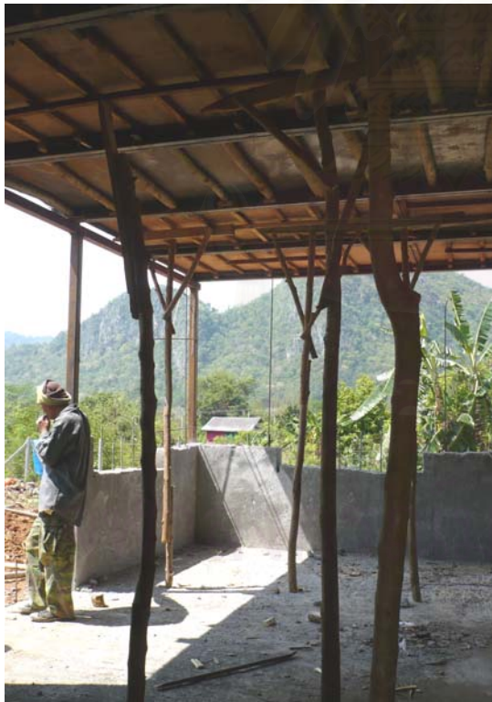
รูปที่ 5.1 แสดงการก่อสร้างตัวอย่างอาคารบ้านพักอาศัย 2 ชั้น ขนาด 100 ตารางเมตร ที่มีเปลือกอาคารเป็นวัสดุโฟมคอนกรีตหนา 0.20 เมตร โดยสามารถลดระยะเวลาการก่อสร้างได้ถึง 3 เท่า (สถานที่ก่อสร้างในโครงการ อีโค-สเฟียร์ เขาใหญ่ จังหวัดนครราชสีมา วันที่ 2 เมษายน 2551)
