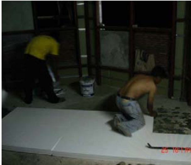
รูปที่ 3.13 แสดงการติดตั้งพื้นฉนวน EPS เพื่อป้องกันความร้อนจากพื้น
