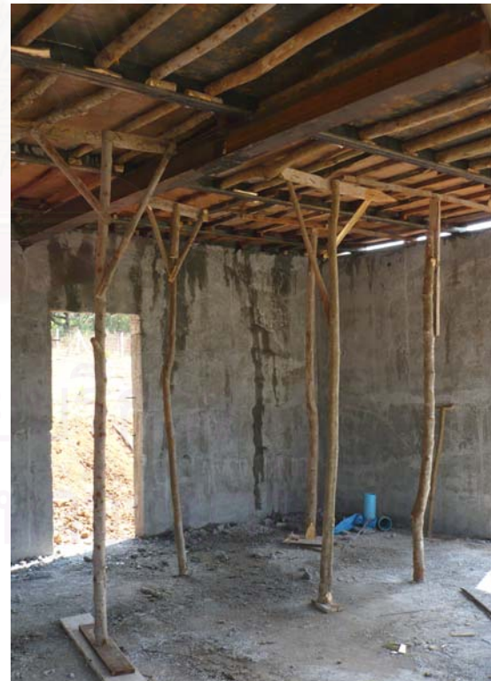
รูปที่ 5.1 แสดงการก่อสร้างตัวอย่างอาคารบ้านพักอาศัย 2 ชั้น ขนาด 100 ตารางเมตร ที่มีเปลือกอาคารเป็นวัสดุโฟมคอนกรีตหนา 0.20 เมตร โดยสามารถลดระยะเวลาการก่อสร้างได้ถึง 3 เท่า (สถานที่ก่อสร้างในโครงการ อีโค-สเฟียร์ เขาใหญ่ จังหวัดนครราชสีมา วันที่ 2 เมษายน 2551)
