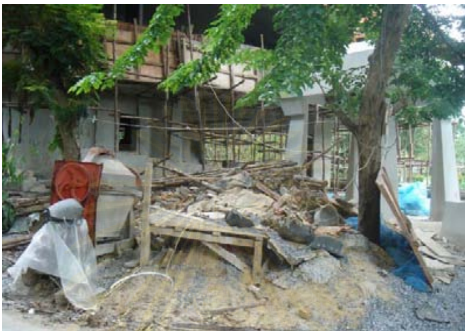
รูปที่ 1.19 พื้นที่ก่อสร้างที่คับแคบ ต้องก่อวัสดุปนกัน เกิดการสูญเสียวัด
