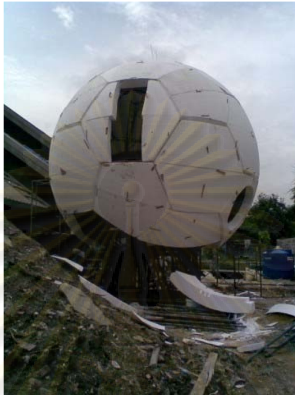
รูปที่ 4.32 การทดลองหุ้มเปลือกอาคารบ้านทรงสเฟียร์ แบบโดมจีโอเดสิก (Geodesic Dome)
