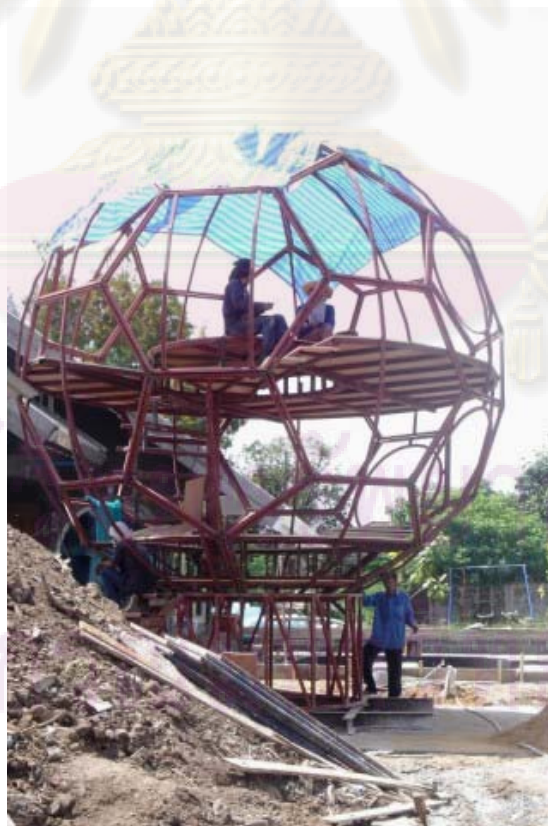
รูปที่ 4.27 การทดลองประกอบโครงสร้างโดมจีโอเดสิก (Geodesic Dome) บ้านทรงสเฟียร์
