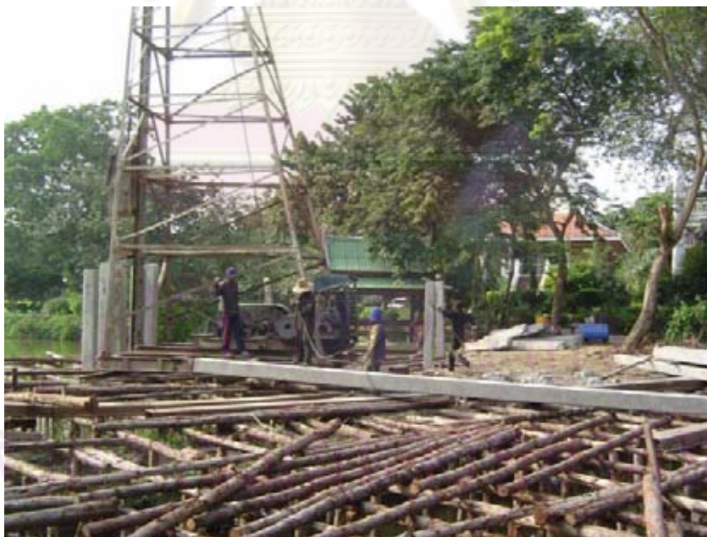
รูปที่ 1.14 การทำนั้งร้านด้วยไม้สน เพื่อตอกเสาเข็มในบ่อน้ำ
