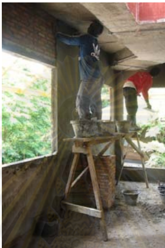
รูปที่ 1.21 การฉาบปูนผนัง ซึ่งเป็นงานเป็ยงและสกปรกมาก
