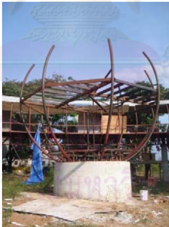
รูปที่ 4.29 โครงสร้างบ้านทรงสเฟียร์ จากการลดเนื้อวัสดุที่ไม่จำเป็น
