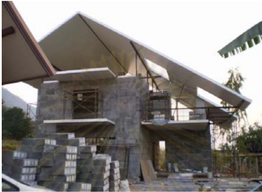
รูปที่ 5.15 ลักษณะการก่อโฟมซีเมนต์บล็อค อาคารบ้านผู้ใจร้อน
