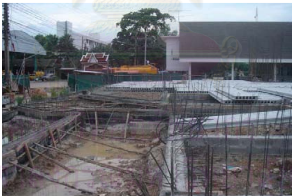
รูปที่ 1.3 การก่อสร้างคานพื้นชั้น 1
