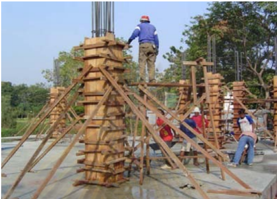
รูปที่ 1.17 การหล่อเสาคอนกรีตเสริมเหล็กที่มีชั้นตอนหลายชั้นตอน
