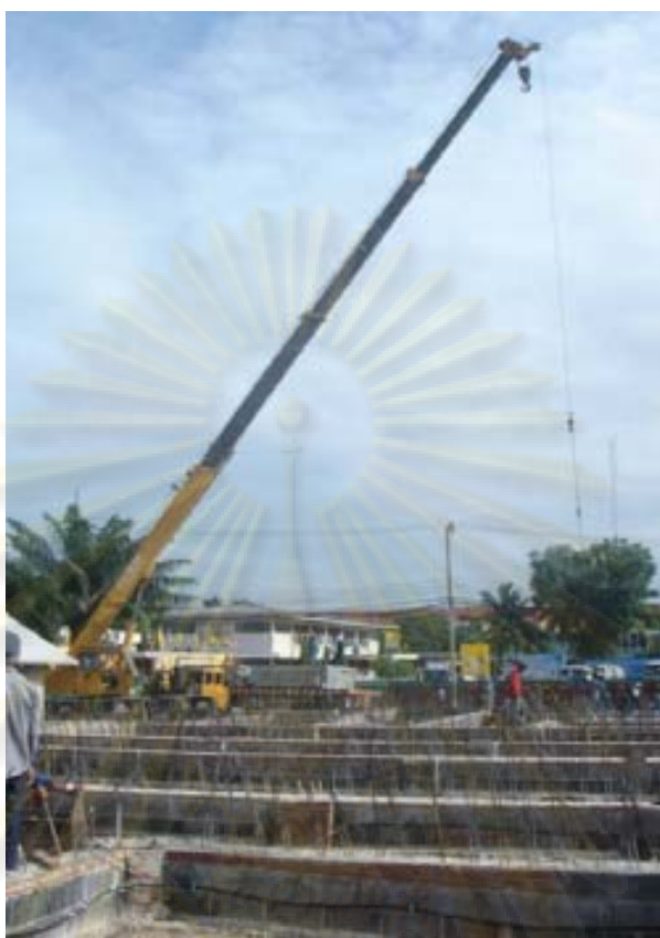
รูปที่ 1.4 การใช้รถเครนขนาด 25 ตัน เพื่อยกแผ่นพื้นสำเร็จรูปแบบกลวง
