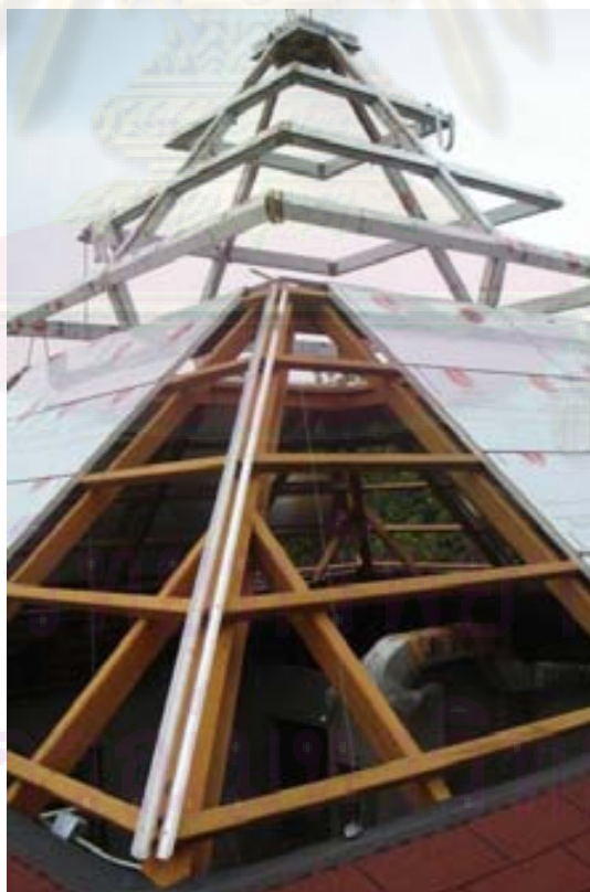
รูปที่ 1.24 การติดตั้งแผ่นอะลูมิเนียมคอมโพสิต (Aluminium Composit panel) บนช่องแสงยอดหลังคา
