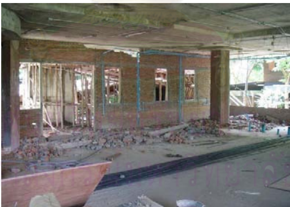
รูปที่ 1.20 การแก้ไขปรับปรุงผนังก่ออิฐ ต้องทุบผนังแล้วขนทิ้ง
