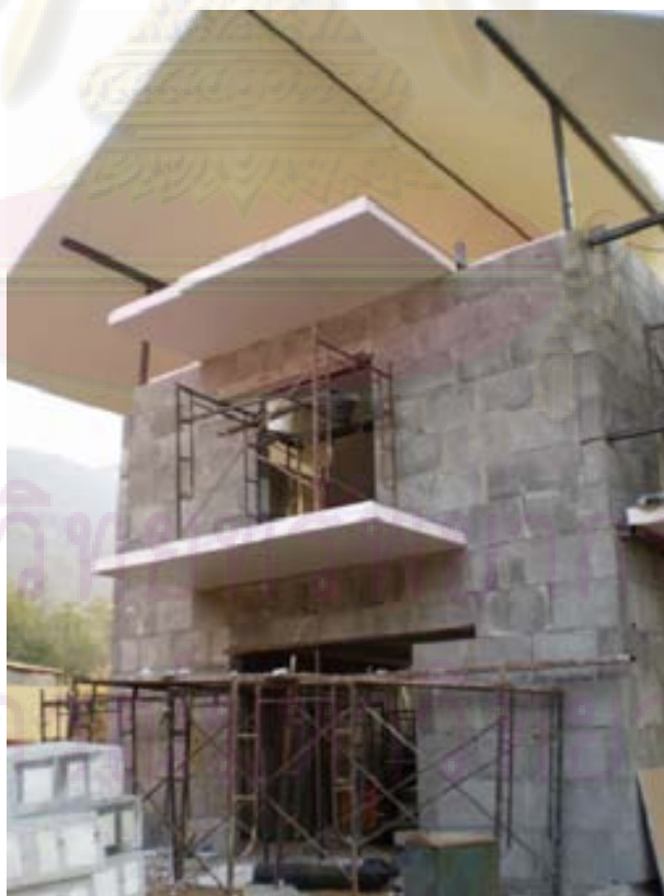
รูปที่ 5.14 พื้น Sandwich insulation panel ยื่นเป็นระเบียงภายนอก
