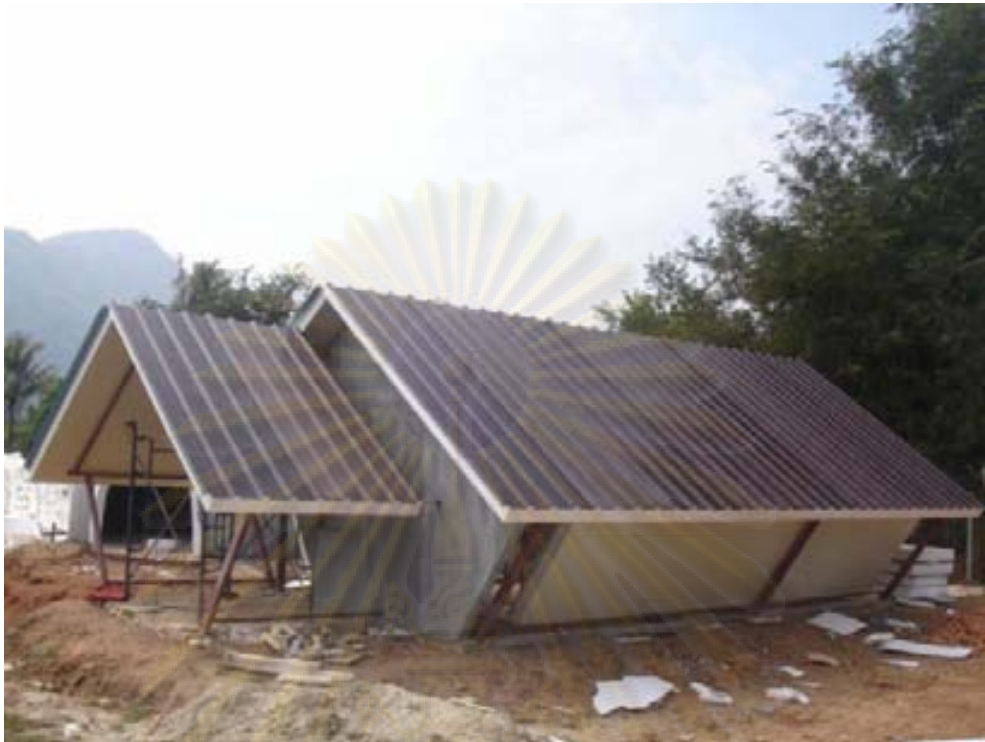
รูปที่ 4.16 รูปด้านข้างบ้านทรงโดมอนด์ เมื่อติดตั้งหลังคาและผนังสำเร็จรูป
