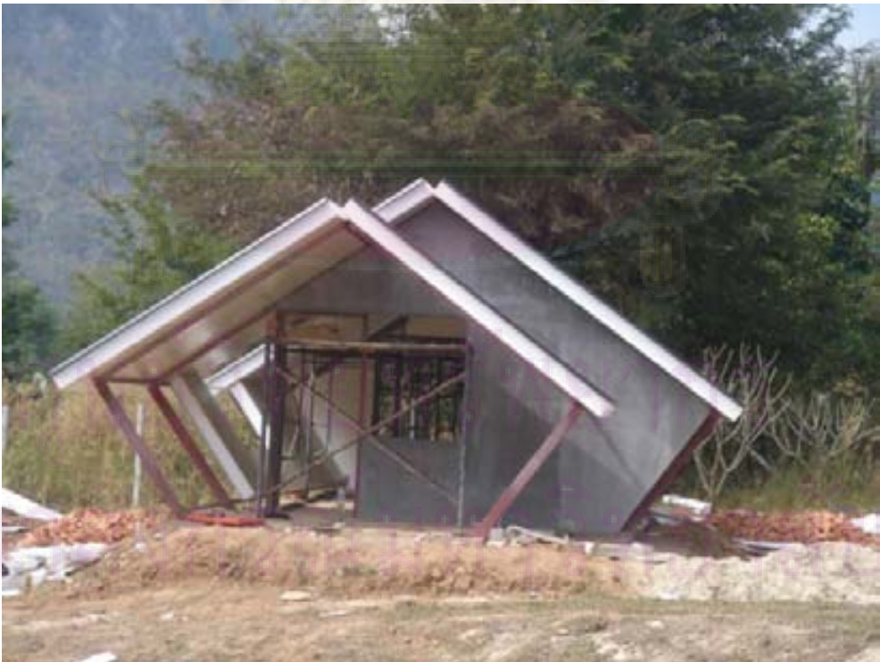
รูปที่ 4.15 เมื่อติดตั้งหลังคาสำเร็จรูปบ้านทรงโดมอนด์ แล้วเสร็จ
