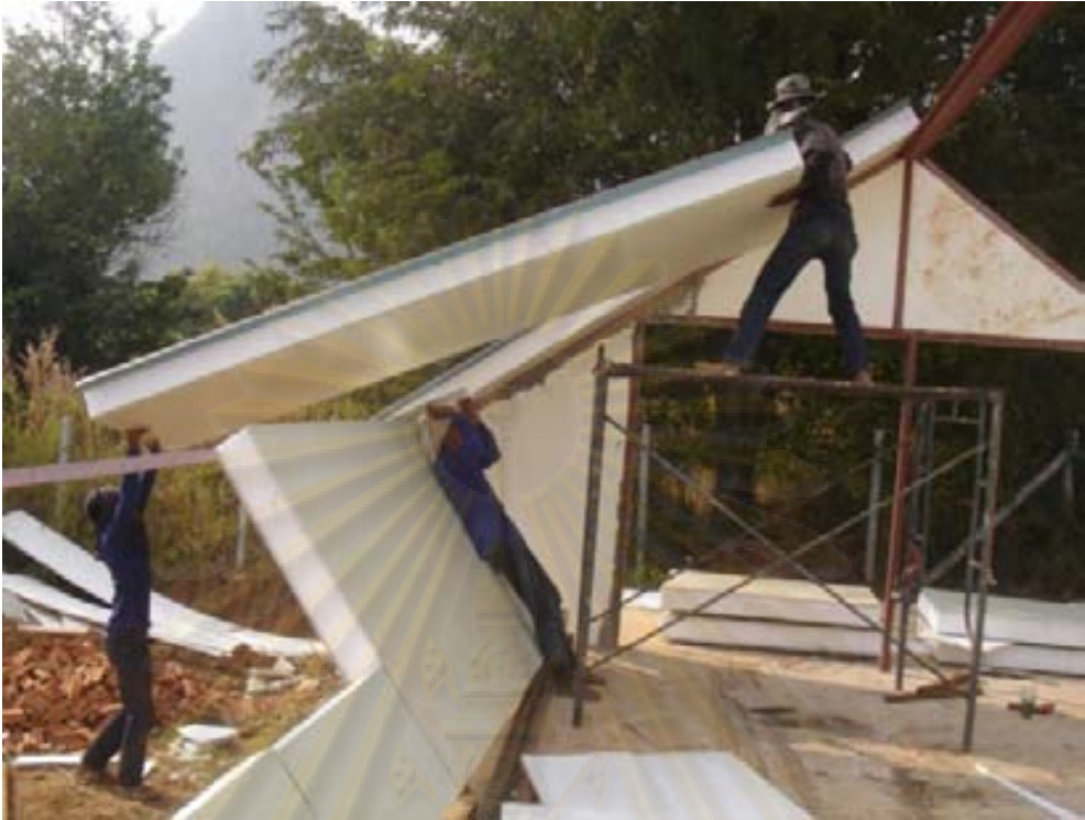
รูปที่ 4.14 การติดตั้งแผ่นหลังคาสำเร็จรูปด้วยแรงงานคน ของบ้านทรงโดมอนด์
