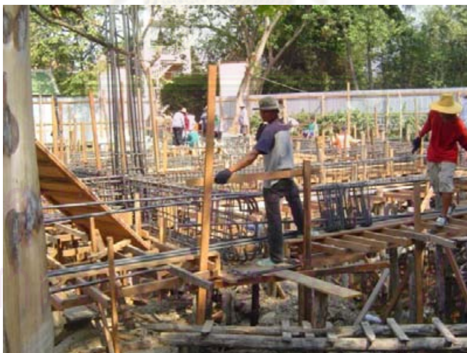
รูปที่ 1.16 ความยุ่งยากในการทำแบบ และผูกเหล็กคาน
