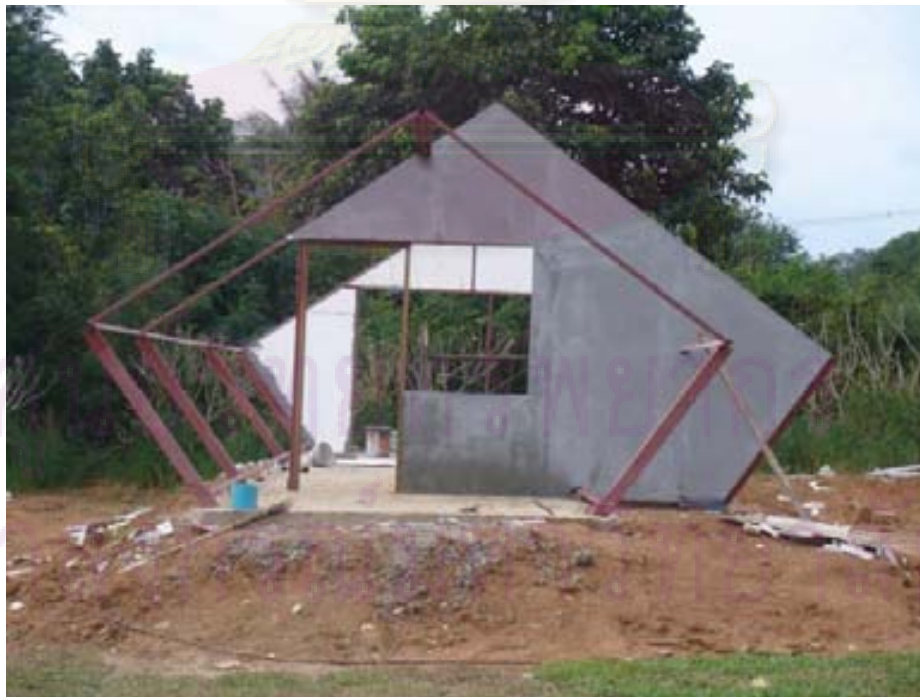
รูปที่ 4.13 ด้านหน้าบ้านทรงโดมอนด์ ติดตั้งผนัง EIFS
