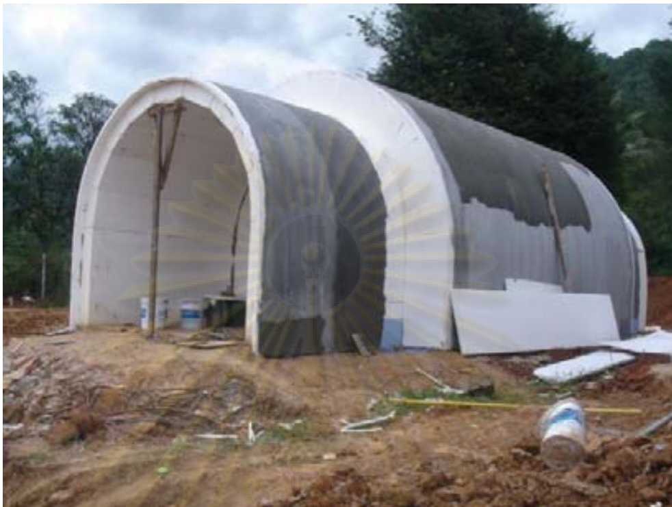
รูปที่ 4.20 ฉาบผิวโครงสร้างโฟม พร้อมเสริมตาข่าย บ้านทรงโกล์ท
