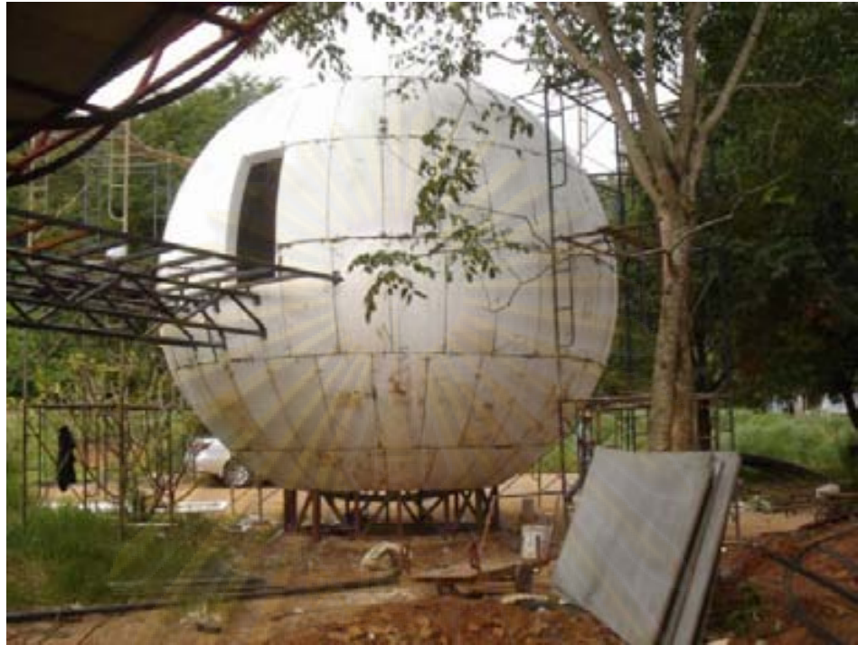
รูปที่ 4.30 ชั้นส่วนประกอบเปลือกอาคารบ้านทรงสเฟียร์ ที่ค้ำยันถึงขนาดของวัสดุ
