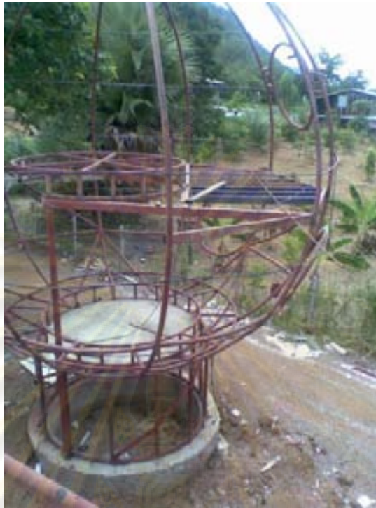
รูปที่ 4.28 โครงสร้างเหล็กรูปกลีบส้ม บ้านทรงสเฟียร์
