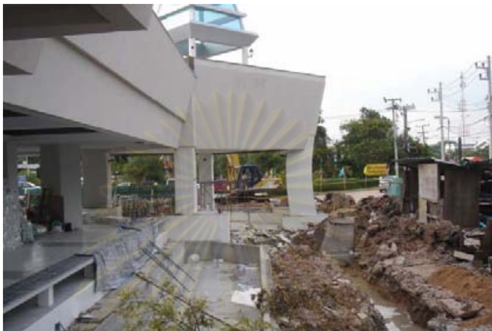
รูปที่ 1.12 การก่อสร้างทางระบายน้ำรอบอาคารภายหลังจากสร้างอาคารแล้วเสร็จ
