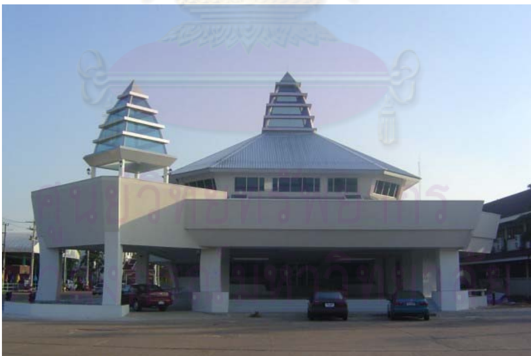
รูปที่ 1.1 อาคารห้องสมุดเฉลิมพระเกียรติฯ จ.ปราจีนบุรี
