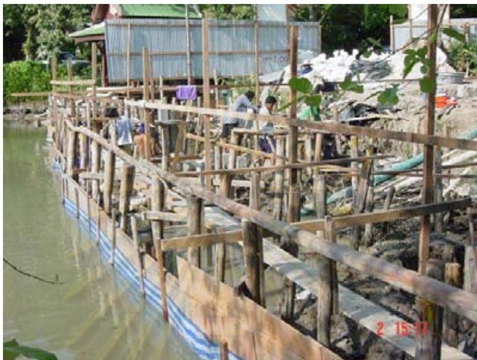
รูปที่ 1.15 การก่อสร้างฐานรากอาคาร ต้องป้องกันน้ำเข้าพื้นที่ก่อสร้าง
