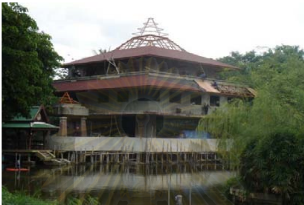
รูปที่ 1.23 การมุงหลังคาชิงเกล็ด (Shingle roof )
