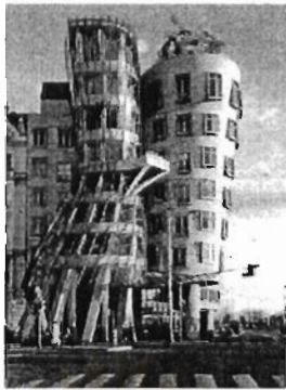
รูปที่ 52 ภาพอาคาร Deconstruction
