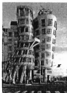
รูปที่ 83 ภาพอาคาร Deconstruction
