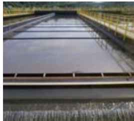
รูปที่ 3.3 ถังตกตะกอนแบบธรรมดา
