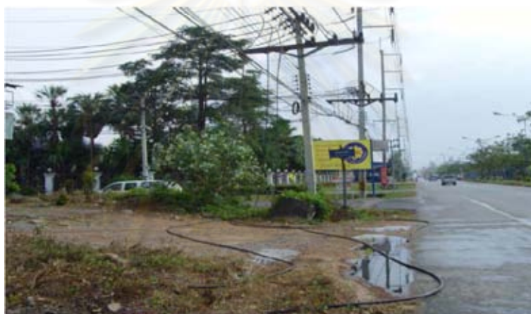
ภาพที่ 1.2 เหตุการณ์สายจ่ายไฟฟ้าขาด 3 เฟสจากสถานที่จริง
