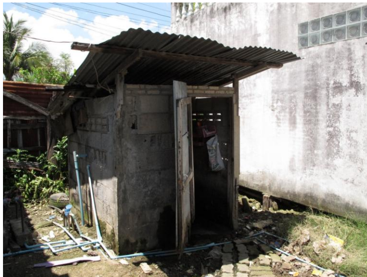
ภาพที่ 4.17 ส้วมที่ไม่ถูกสุขลักษณะในชุมชนซอยวัดหลังบ้าน
