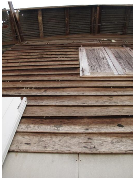
ภาพที่ 4.12 ผนังไม้ผุร่อน
