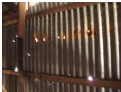
ภาพที่ 4.9 หลังคาสังกะสีที่เก่า ผุ มีรูรั่ว ของบ้านกลุ่มตัวอย่าง
