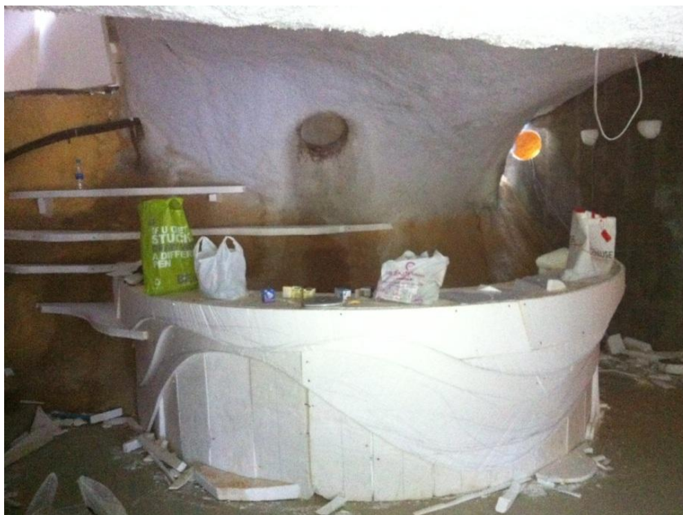
ภาพที่ 4-1 ภาพส่วนโครงสร้างเคาน์เตอร์ต้อนรับ
