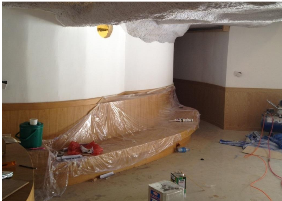
ภาพที่ 4-4 ภาพส่วนงานก่อนสร้างส่วนพักคอย
