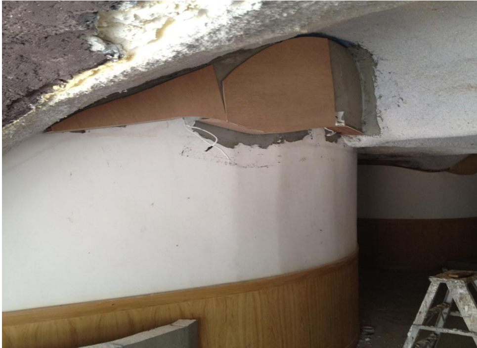
ภาพที่ 4-2 ภาพโครงสร้างผนังเพื่อซ่อนไฟก่อนทำการทดสอบตัวแปร
