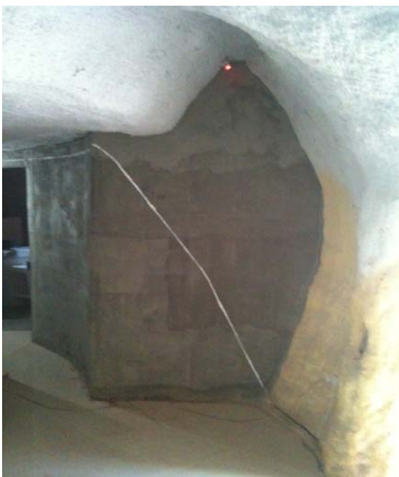
ภาพที่3-13 แสดงที่ว่างภายในผนังรูปทรงอิสระของสปาที่ทำการทดสอบ
