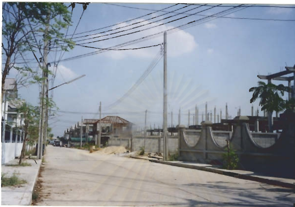
รูปที่ 5 แสดงสภาพภายในโครงการกานดาคลาสสิควิลล์
