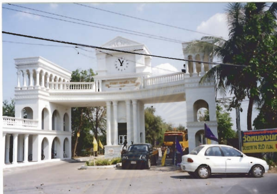
รูปที่ 1 แสดงสภาพด้านหน้าโครงการกานดาคลาสสิควิลล์
