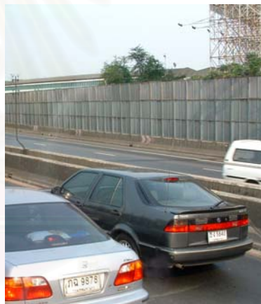
ภาพที่ 3.4.2-1 แสดงตัวอย่างลักษณะกำแพงกันเสียงบนทางด่วน
