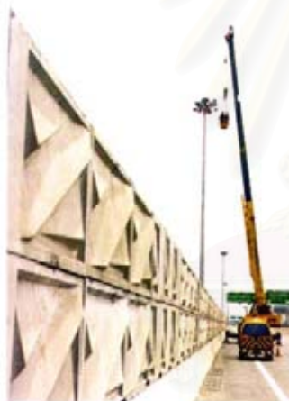
ภาพที่ 3.4.2-1 แสดงตัวอย่างลักษณะกำแพงกันเสียงบนทางด่วน
