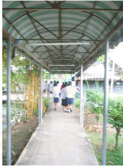
รูปที่ 5.5 แสดงหลังคาคลุมทางเดินที่มีอยู่ในปัจจุบัน
