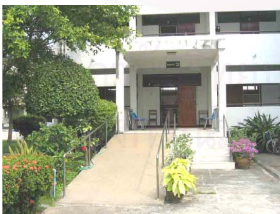
รูปที่ 4.52 แสดงทางเข้าอาคารหอพัก
