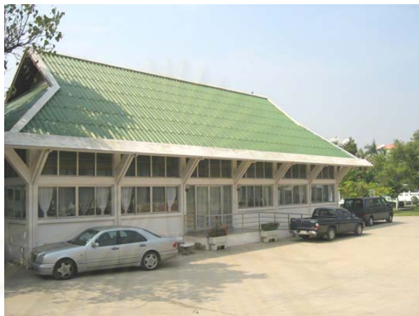
รูปที่ 5.9 แสดงบริเวณลานคอนกรีตกว้าง หน้าอาคารมหาดไทย100ปี
