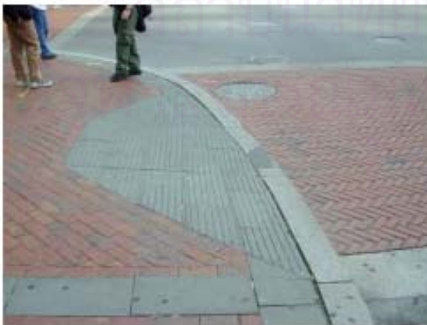
รูปที่ 6.3.ก แสดงตัวอย่างลักษณะจุดขึ้นลงของคนพิการที่ใช้ในการออกแบบ
