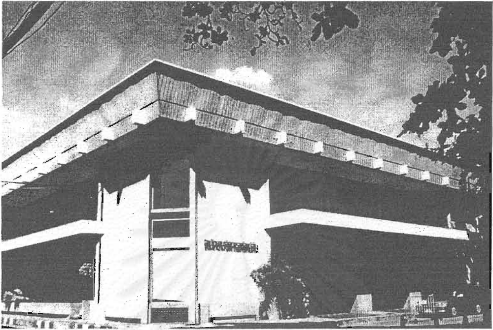
รูปที่ 2-1 สภาพด้านทิศตะวันออกเฉียงใต้ของอาคารสำนักงานจัดการทรัพย์สินฯ
