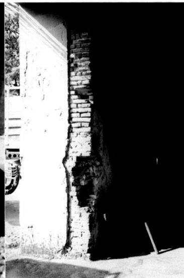
รูปที่4-24 ภาพแสดงผนังรับน้ำหนักที่ห้องโถงชั้นล่าง
