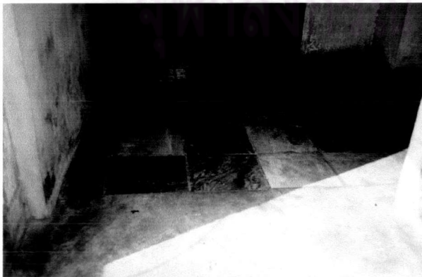
รูปที่ 4-55 ภาพแสดงพื้นหินอ่อนของเดิม มีการเสื่อมสภาพบางส่วน
