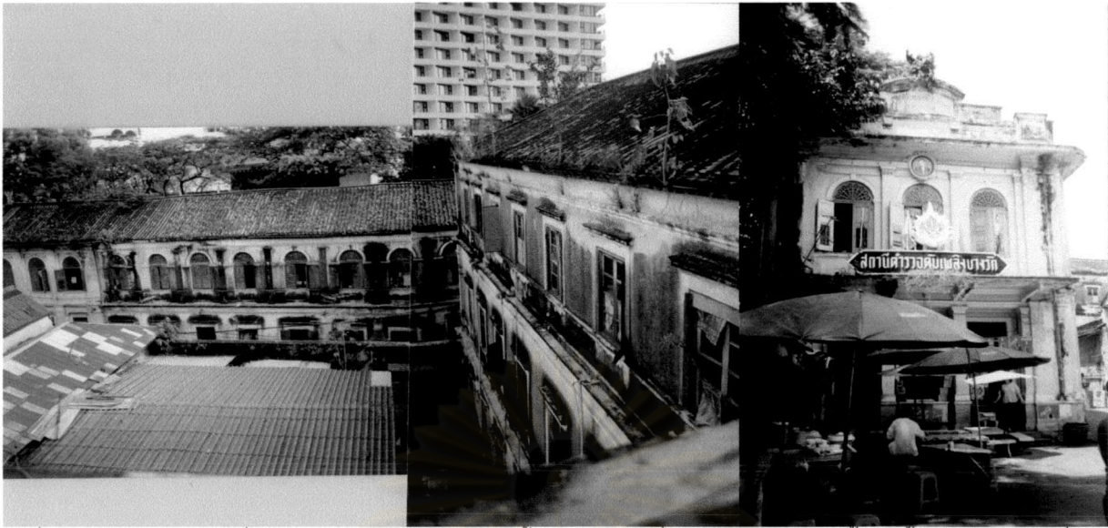
รูปที่ 4-43 ภาพแสดงภาพถ่ายมุมสูงอาคารปึกขวาแสดงให้เห็นถึงการเชื่อมสภาพตลอดทั้งอาคาร
