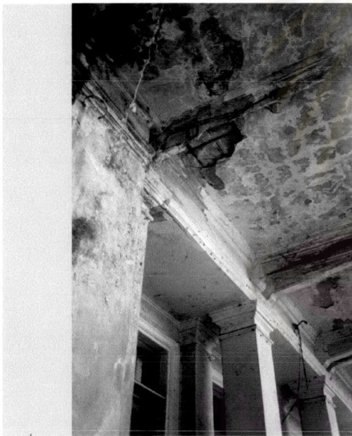
รูปที่ 4-45 ภาพแสดงกันสาดเผยให้เห็นถึงโครงสร้างคอนกรีตเสริมเหล็ก
