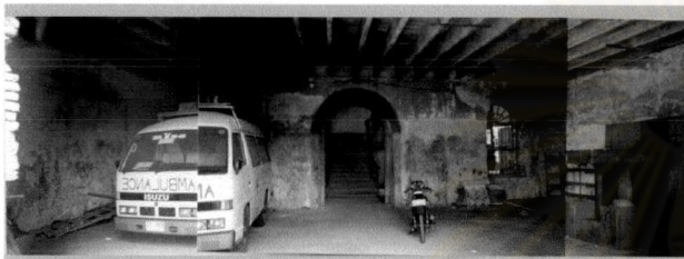
รูปที่ 4-37 ภาพแสดงสภาพความเสียหายห้องโถงชั้นล่าง อาคารประธาณ
