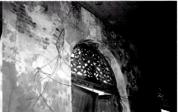
รูปที่ 4-56 ภาพแสดงรากไม้chonไซเข้าไปในผนัง ทำให้แตกกราวเสียหาย
