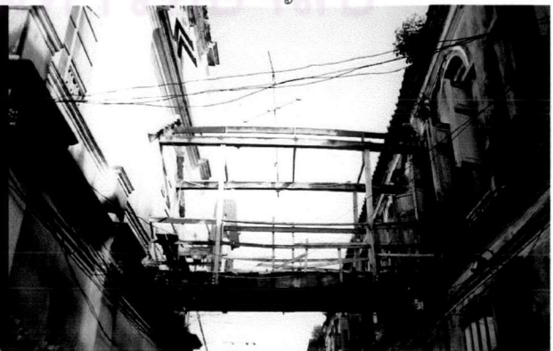
รูปที่ 4-48 ภาพแสดงเคาโครงของทางเชื่อมที่เสียหายเกือบหมด
