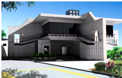
รูปที่ 2.2 แสดงการออกแบบแผงบังแดดให้กับตัวอาคารและช่องเปิดของอาคาร
