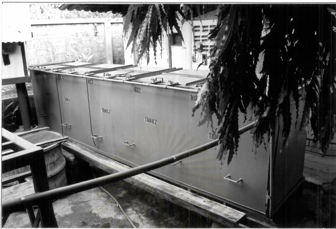
ภาพที่ 3.1 ถังกรองผสมชั้นตัวกลางหลายชนิด บ้านที่ภาพจากสถานที่จริง
