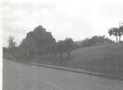
รูปที่ 5.26 แนวกำแพงดินริมถนนประตู่ชัยทางด้านทิศใต้ของเมืองที่มีการก่อสร้างอาคารประชิดแนวกำแพงเมือง
