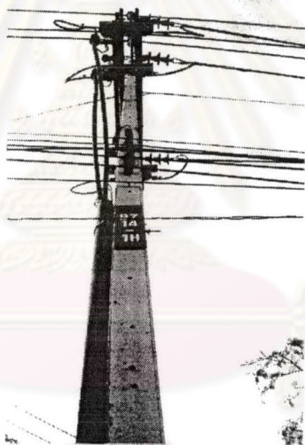
รูปที่ 4.2 ภาพถ่ายเสาโรเซอร์ที่มีสวิตช์ใบมีด BZ14-1H ติดตั้งอยู่
