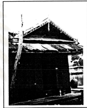
ภาพที่ 4.152 แสดงลักษณะหน้าต่างบานเปิดคู่ที่มีลักษณะสูงลดอย่างเรือนไทย มีการยกขอบหน้าต่างล่างสูงจากพื้นเรือนแพด้านในประมาณ 1 ฟุต และเปิดออกทางด้านข้างออกมาที่ทางเดินรอบแพเมื่อเปิดทั้งหมดจะเป็นการเชื่อมพื้นที่จากข้างนอกสู่ข้างใน(ภาพจากเรือนแพของ ค.ศิริรักษ์)
