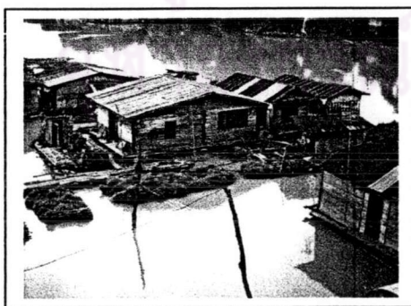
ภาพที่ 4.105 แสดงเรือนแพแบบหลังคาต่อกันของทรงจั่วลาดคนละความชันหลังคา
