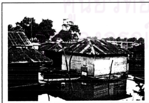
ภาพที่ 4.99แสดงเรือนแพแบบหลังคาแปดสอง ทรงปั้นหยา
