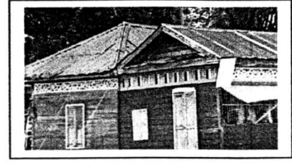
ภาพที่ 4.166 ภาพแสดงลักษณะไม้ฉลุลาย ที่ทำเป็นช่องระบายอากาศซึ่งอยู่ตอนบน ของฝาผนังแพพบที่เรือนแพบริเวณริม สะพานพัฒนาภาคเหนือ(แพคุณรุ่งฟ้า แพ เลขที่26)
