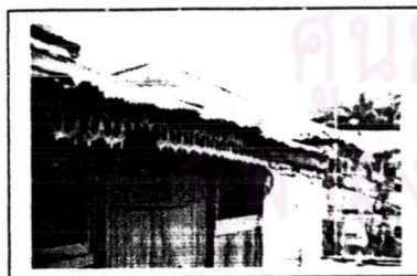
ภาพที่ 4.161 แสดงลักษณะไม้ฉลุ ลายที่งดงามติดเชิงชายหลังคาตลอด แนว ของเรือนแพ ศ.ศิริรักษ์ ซึ่งจะ สังเกตได้ถึงการชำรุดบางส่วน
