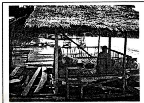
ภาพที่ 4.112 หลังคาสวนศาลาพักผ่อนมุงด้วยตับจาก
