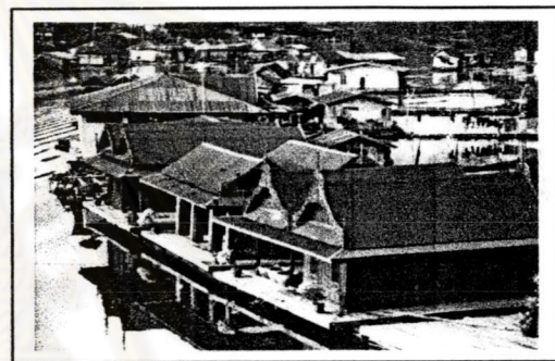
ภาพที่ 4.168 เรือนแพรับรองมีการแสดงลักษณะไม้ฉลุลายที่ ติดตามแนวชายหลังคา และหน้าจั่ว
