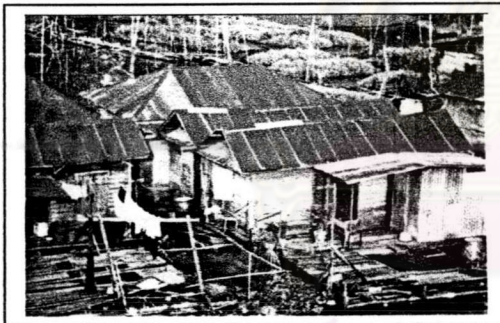
ภาพที่ 4.103 แสดงเรือนแพแบบหลังคาต่อกันของทรงจั่วลาดและปั้นหยา
