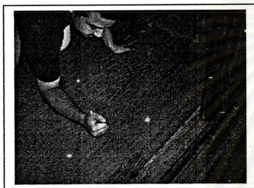
ภาพที่ 4.130 ภาพแสดงพื้นไม้สักในเรือน(ขนาดหน้ากว้าง 2ฟุต)ของแพคุณป้าสุใจ แพเลขที่16
