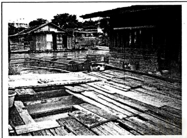
ภาพที่ 4.45 แสดงการใช้งานหลากหลายของพื้นที่นอกชานแพ โดย ทำการเจาะช่องไว้ทำกระชังปลา
