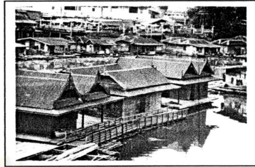
ภาพที่ 4.102 แสดงเรือนแพแบบหลังคาแฝดสองทงไทย
