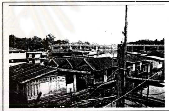
ภาพที่ 4.98แสดงเรือนแพแบบหลังคาแปด สามทรงจั่วลาด
