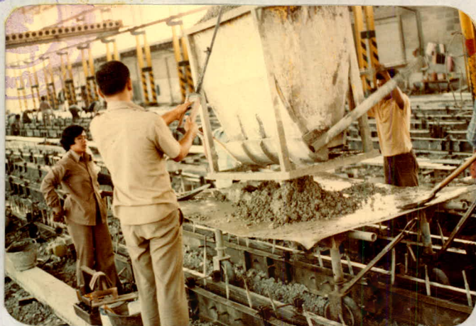
ภาพที่ 10 : งานเกี่ยวกับคอนกรีต : เป็นการลำเลียงคอนกรีตมาเทลงกะบะรับคอนกรีตและตักเท คอนกรีตลงในแบบเสาที่จัดเตรียมไว้พร้อม ซึ่งเสียบเหล็กทำรู เสาครบจำนวนตามแม่แบบเรียบร้อยแล้ว
