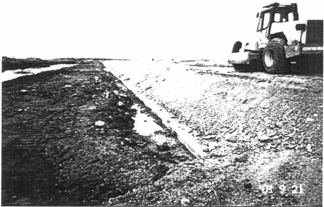
รูปที่ ก.5 แสดงการบดอัดคันดินถนน
