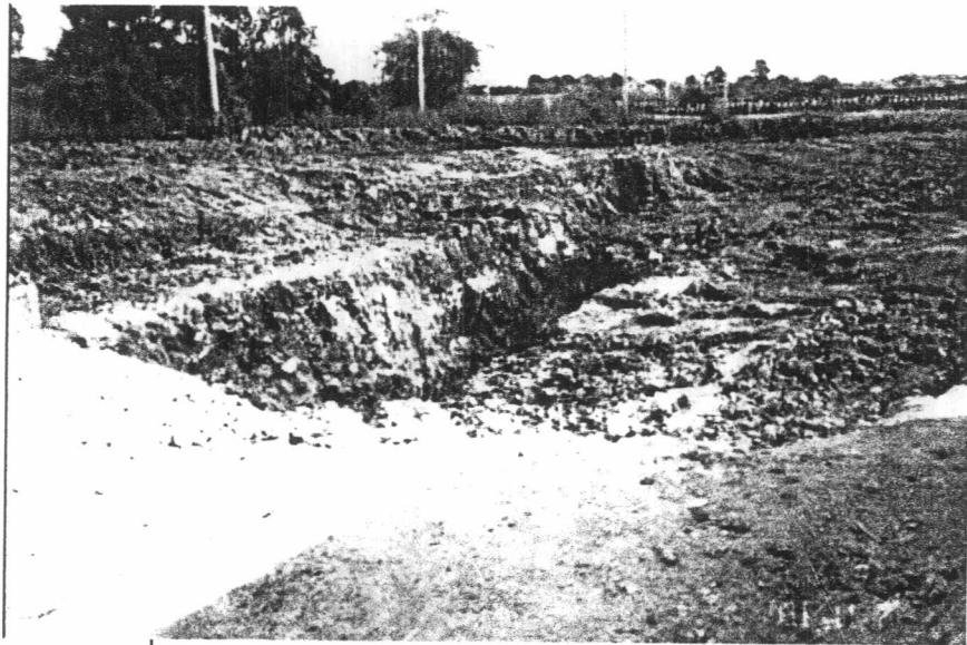
รูปที่ 4.8 แสดงบ่อขุดหลังจากทำการถมดินกลับเรียบร้อยแล้ว
