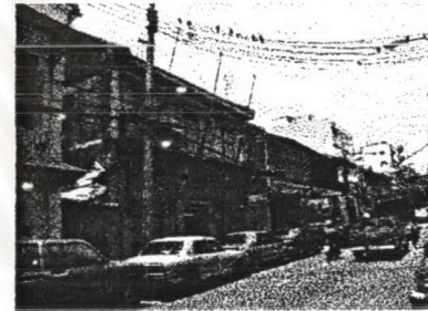
เสาไฟฟ้าและโครงข่ายสายไฟ
