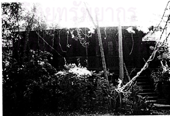
รูปที่ ๕.๑๒ บ้านพักบริษัทบริติชบอร์เนียวหมายเลข ๖ รูปแบบงานสถาปัตยกรรมแบบอาณานิคม
