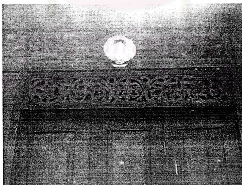
รูปที่.๓.๒.๑๗ ลายฉลุช่องลมเหนือประตูทางเข้า
