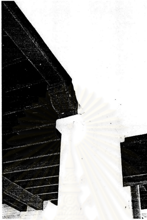
รูปที่.๓.๔.๑๓ การล๊อกันระหว่างหัวเสาปูนและหัวเสาไม้
