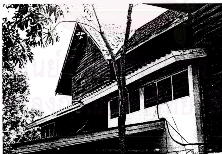
รูปที่.๓.๓.๕ ด้านหลังอาคารซึ่งได้มีการต่อเติมภายหลัง
