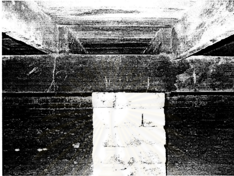
รูปที่.๓.๔.๑๕ โครงสร้างรับน้ำหนักใต้พื้นของอาคาร
