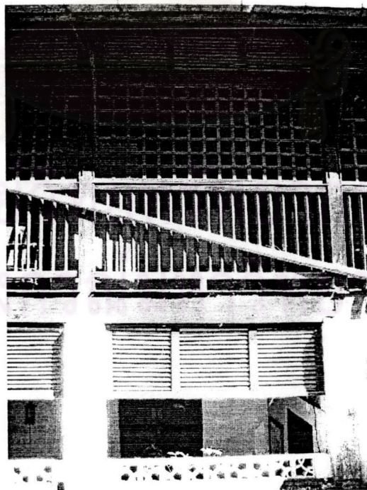
รูปที่.๓.๓.๑๑ การประดับอาคารโดยการใช้ฝ้าไม้ตีระแนงและการใช้บานเกล็ดบังแสง
