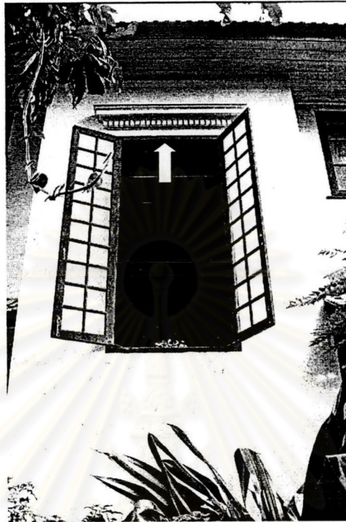
รูปที่.๓.๕.๑๐ แสดงการตกแต่งภายนอกอาคารโดยการใช้ปูนประดับเหนือช่องหน้าต่างบันได
