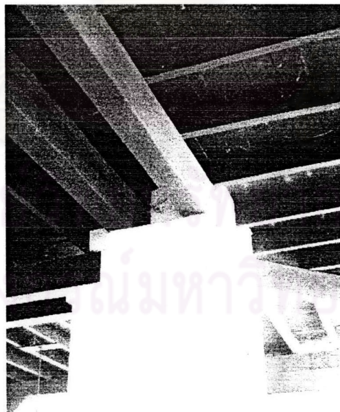
รูปที่.๓.๔.๑๓ การล๊อกันระหว่างหัวเสาปูนและหัวเสาไม้
