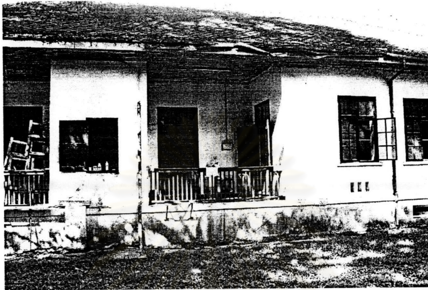
รูปที่.๓.๔.๒๕ ด้านข้างอาคารรับรอง
