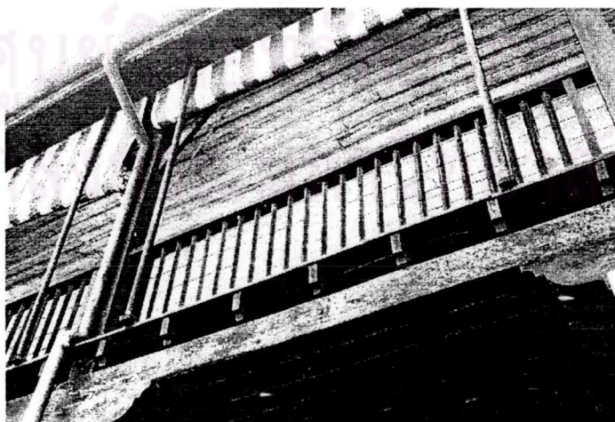
รูปที่.๓.๔.๑๘ ส่วนประดับอาคารที่เกิดจากโครงสร้างไม้
