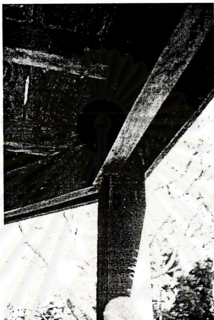
รูปที่.๓.๒.๑๐ โครงสร้างพื้นไม้บริเวณมุขยื่นของบ้าน
