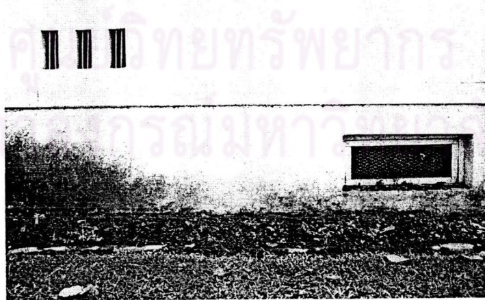
รูปที่.๓.๔.๒๖ ช่องระบายอากาศ
