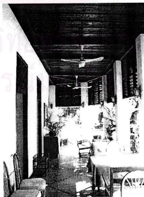
รูปที่.๓.๓.๙ โครงสร้างชั้นล่างของอาคาร
