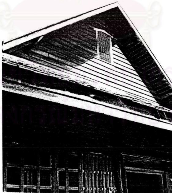
รูปที่.๓.๓๙ ช่องลมบริเวณหน้าจั่วอาคาร
