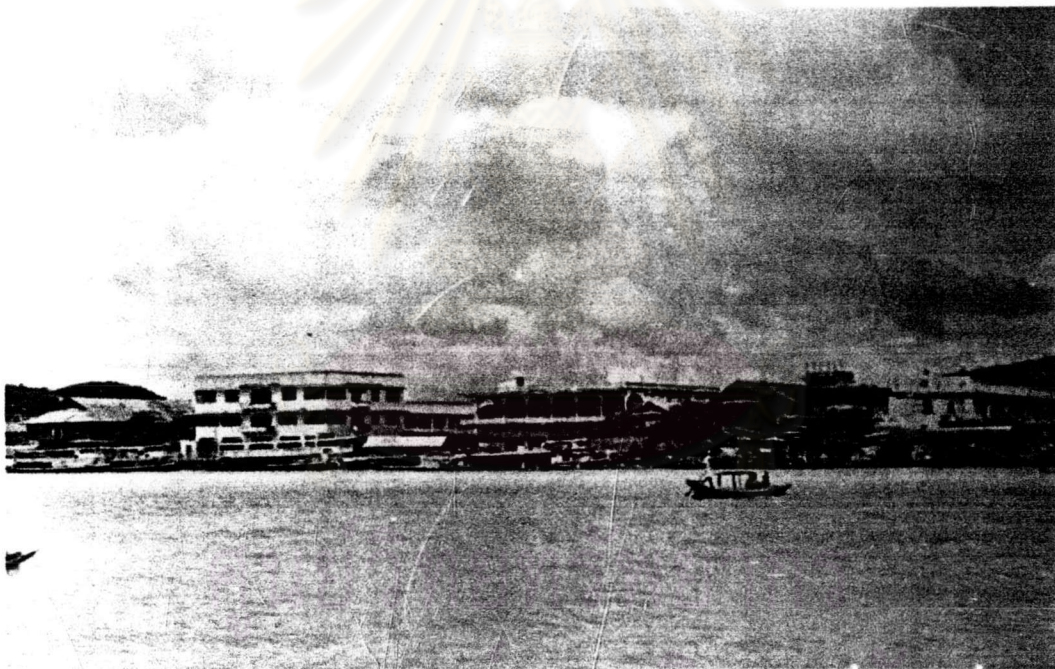
ภาพที่ 4.16 ภาพโรงแรมสวัสดิ์ค้าไม้ ดึกขาว หนีมัง ไทยอารีย์ เป็นลักษณะอาคารที่โดดเด่นในอดีต
