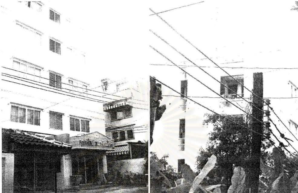
รูปภาพที่ 4.4 สุขสถิตย์ อพาร์ทเมนต์
