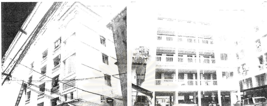
รูปภาพที่ 4.21 แสดงการวาง ตำแหน่งบันได ไว้ที่ตำแหน่งห้องริมสุดของอาคาร
