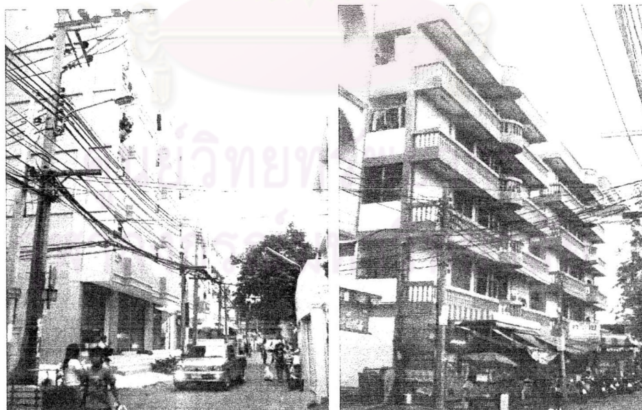
รูปภาพที่ 4.10 แสดงตัวอย่างอาคารที่มีความสูงของอาคาร ไม่เกิน 2 เท่าของ ระยะตั้งฉากกับแนวถนนด้านตรงข้าม
