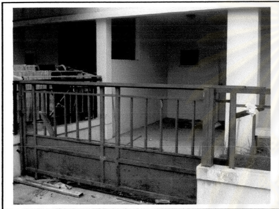
รูปภาพที่ 5.5 แสดงขนาดที่จอดรถใน บ้านที่เข้าหลักเกณฑ์การส่งเสริมการลงทุน โครงการพฤษา 9
