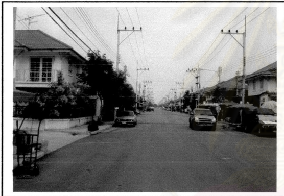
รูปภาพที่ 5.33 แสดงถนน ค.ส.ล. กว้าง 16 ม.
