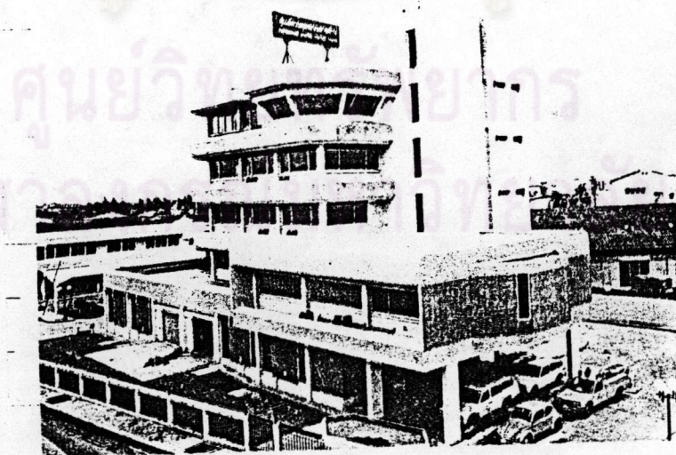
อาคารศูนย์ควบคุมระบบทางด่วนฯ ทัด.เกษมราษฎร์ บริเวณท่าเรือคลองเตย
