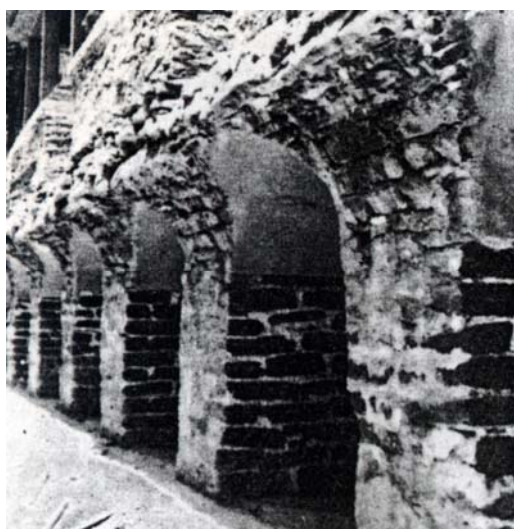
ภาพที่ 5.14 ภาพแสดงการก่ออิฐโครงสร้างชั้นล่างเป็นแบบขุ่มโค้ง (ที่มา : กรมศิลปากร, โลหะปราสาท วัดราชนัลดารามวรวิหาร, หน้า 166.)
