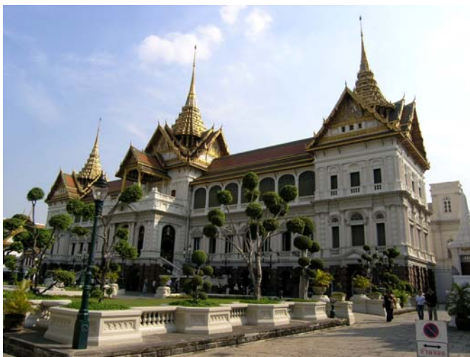
ภาพที่ 7.14 พระที่นั่งจักรีมหาปราสาทภายหลังปรับปรุง ในสมัยรัชกาลที่ 7 เครื่องหลังคาจั่ว เปลี่ยนเป็นเครื่องลายของแบบนาครวย และนาครสะดุ้ง มีช่อฟ้า ไบระกา หางหงส์ ใช้ คันทวยรับไขราของเครื่องยอด จากเดิมเป็นครุฑยุคนาค และมีการเปลี่ยนลายหน้า บันใหม่ทุกด้าน ส่วนมุขเด็จขยายจนสุดพระระเบียง บริเวณคอกสองมีการเปลี่ยน รูปแบบเป็นลูกฟัก แทนซุ้มแบบตะวันตก
