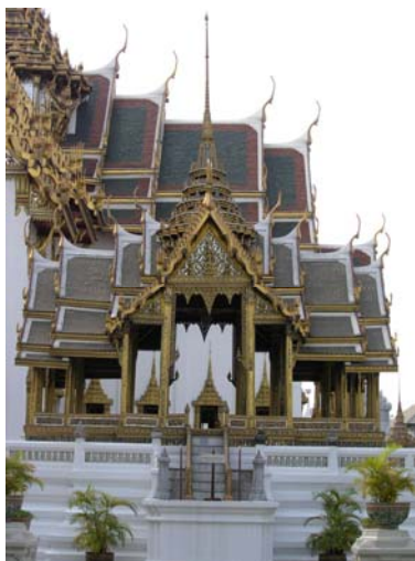
ภาพที่ 7.9 พระที่นั่งอาภรณ์ภิโมกข์ปราสาท แนวความคิดในการสร้างพระที่นั่งโถง ประกอบด้วยเครื่องยอด 5 ชั้น บริเวณไชราเครื่องยอดประกอบด้วยรูปหงส์ แทนครุฑยุคนาค (ที่มา : สถาปัตยกรรมพระบรมมหาราชวัง เล่ม 1 ),
