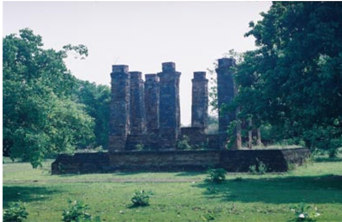
ภาพที่ 4.14 มณฑปเทวาลัยเกษตรพิมานก่อโครงสร้างของเสาแยกจากผนัง (ที่มา : วิรัตน์ ยงรอด และ ธวัชชัย อังค์วุฒิเวทย์, สุขโขทัย ศรีสัตนาลัย, หน้า 120).
