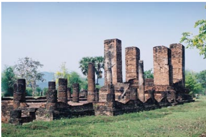
ภาพที่ 4.13 มณฑปวัดศรีโกล จากร่องรอยเห็นการก่อผนังแยกจากเสาอย่างเห็นได้ชัด (ที่มา : วิรัตน์ ยั่งรอด และ ธวัชชัย องศ์วุฒิเวทย์, สุโขทัย ศรีสัตนาลัย, หน้า 118).
