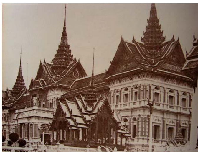
ภาพที่ 7.13 พระที่นั่งจักรีมหาปราสาทในระยะที่สอง มีการซ่อมแซมปรับปรุง บริเวณซอฟต์แวร์ให้เป็นแบบซอฟต์แวร์รวม บริเวณมุขเด็จมีการลดขนาดให้สั้นลง (ที่มา: สมุดภาพสถาปัตยกรรมกรุงรัตนโกสินทร์), หน้า 236.
