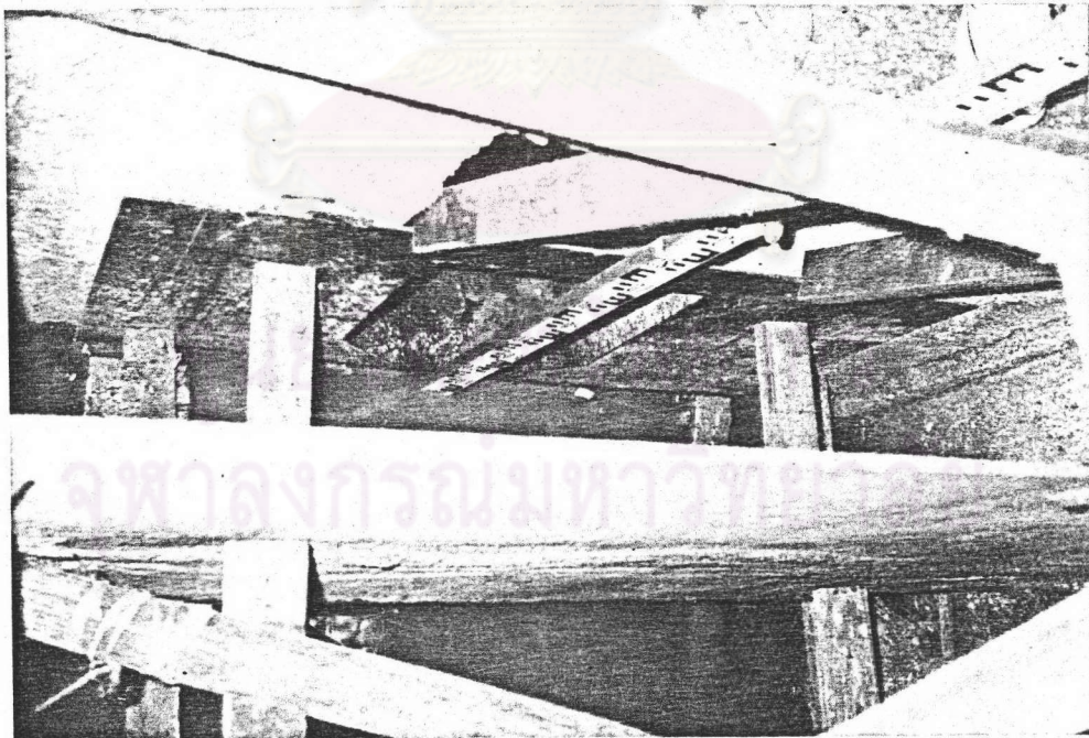
รูปที่ ค-8 ติดตั้งฝายวัดอัตราการไหลที่บ่อนักจุดไหลออก
