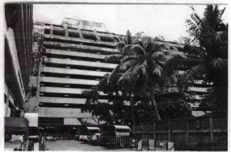
(6) อาคารจอดรถห้างโรบินสันบางรัก
