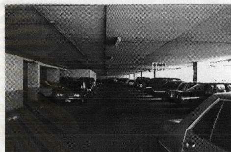
(4) ที่จอดรถยนต์ภายในอาคาร
