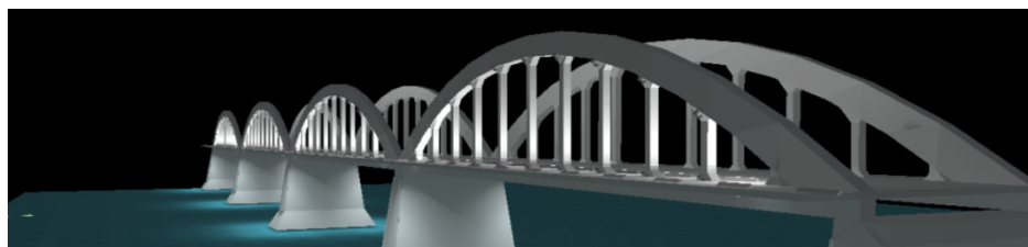
ภาพที่ 6.6.7 การส่องสว่างสะพานรัฐภาภิเศกโดยใช้หลอดฟลูออเรสเซนต์ส่องไปยังระนาบด้านล่างโค้ง ที่มา: ผู้วิจัย
