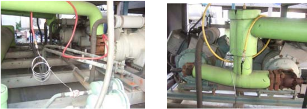
ภาพที่ 5.12 ตำแหน่งที่ทำการติดตั้ง Pressure transmitter
