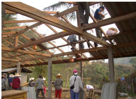
รูปภาพ 2.6 โครงสร้าง: การก่อสร้างอาคารโรงอาหารขนาด 5×16 เมตร
