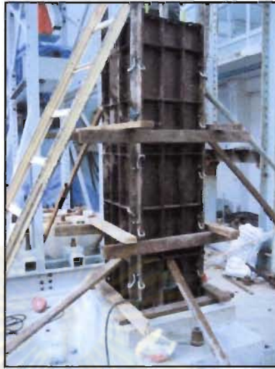
รูปที่ 3.6 แสดงตัวอย่างการเข้าแบบหล่อเสาคอนกรีต
