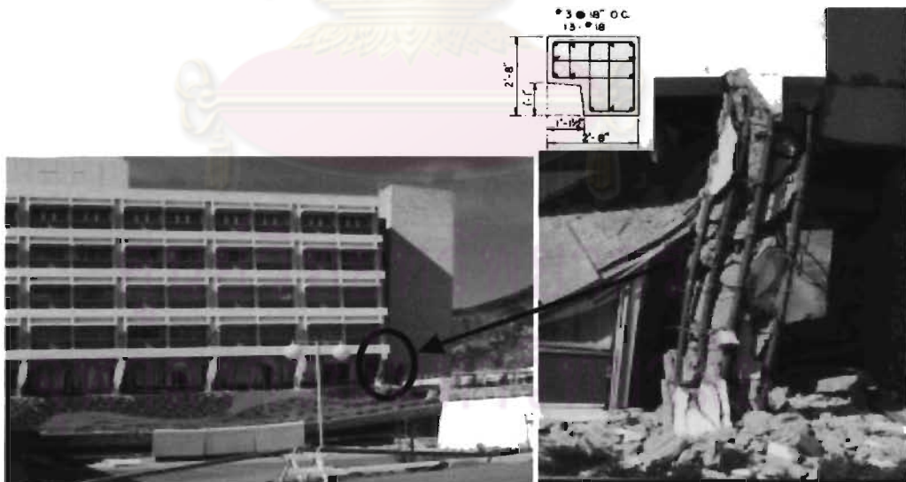
รูปที่ 1.2 ความเสียหายของโรงพยาบาลในเหตุการณ์แผ่นดินไหว San Fernando ในปี 1971 (Steinbrugge K. V., NISEE Database)
