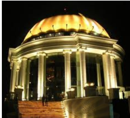
ภาพที่ 4.88 ภาพถ่ายจริงของอาคาร State tower
