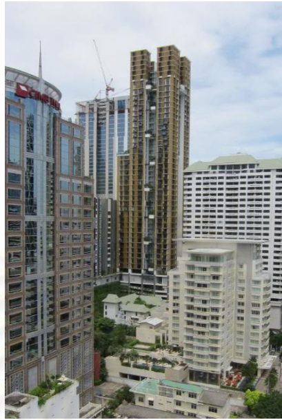
ภาพที่ 4.60 แสดงรูปถ่ายในปัจจุบันของ อาคาร Hansa hotel
