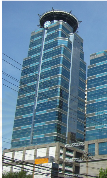
ภาพที่ 4.58 แสดงรูปถ่ายในปัจจุบันของ อาคาร K-Tower
