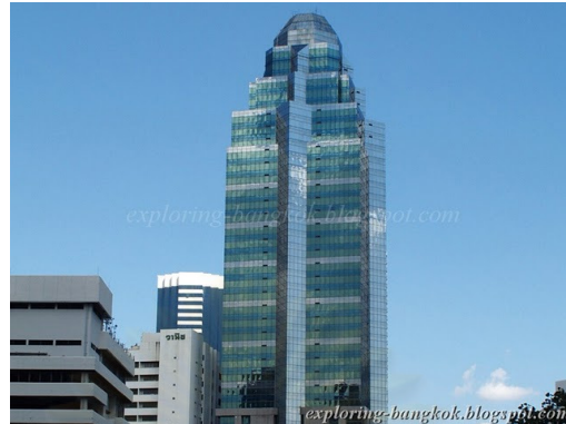
ภาพที่ 4.4 แสดงรูปถ่ายในปัจจุบันของอาคาร วานิช ทาวเวอร์ 2
