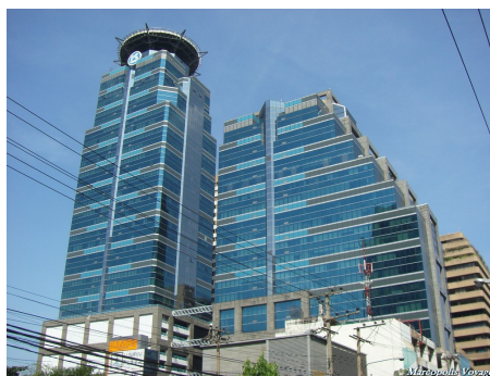
ภาพที่ 4.124 ภาพถ่ายจริงของอาคาร K-Tower
