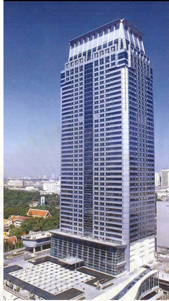
ภาพที่ 4.24 แสดงรูปถ่ายในปัจจุบันของอาคาร Central World tower
