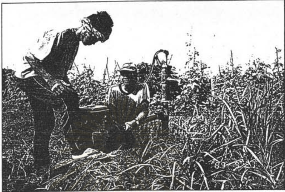
รูปที่ 5-3 การติดตั้งปั๊มปลูบน้ำจากบ่อบาดาลชนิดใช้เครื่องสูบมือโยก เพื่อใช้ในการเกษตรกรรม
