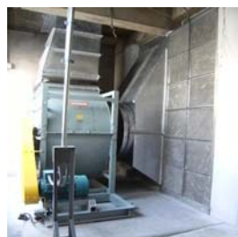
รูปที่ 3.38 หลังการติดตั้ง
