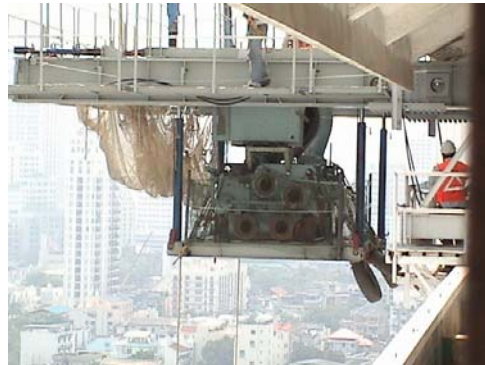
รูปที่ 3.34 ขณะทำการติดตั้ง
