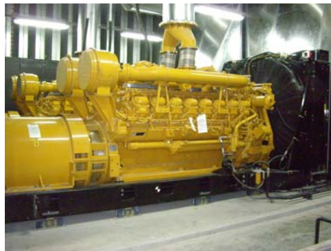
รูปที่ 3.30 หลังการติดตั้ง
