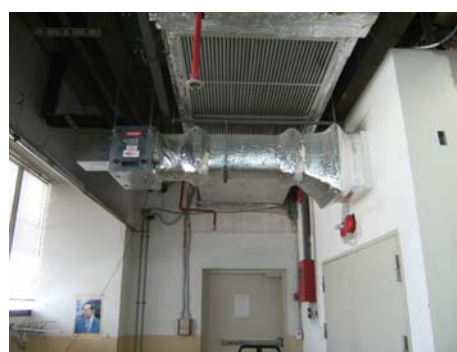
รูปที่ 3.40 หลังการติดตั้ง
