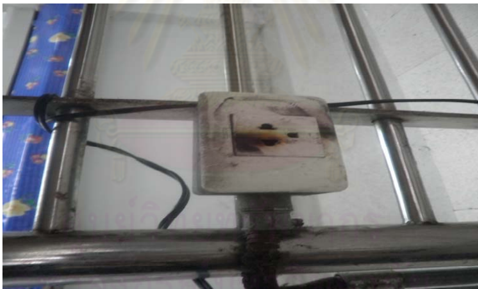
รูปภาพ 4.27 อุปกรณ์ไฟฟ้าที่มีสภาพชำรุดทรุดโทรมบริเวณโรงอาหารรวมอาคารจุฬาพัฒนา 9
