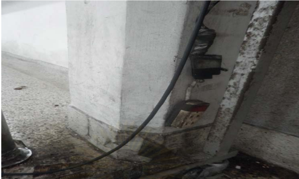
รูปภาพที่ 4.40 สภาพอุปกรณ์ไฟฟ้าที่อยู่ในสภาพเก่าภายในโรงอาหารหอพักนิสิต
