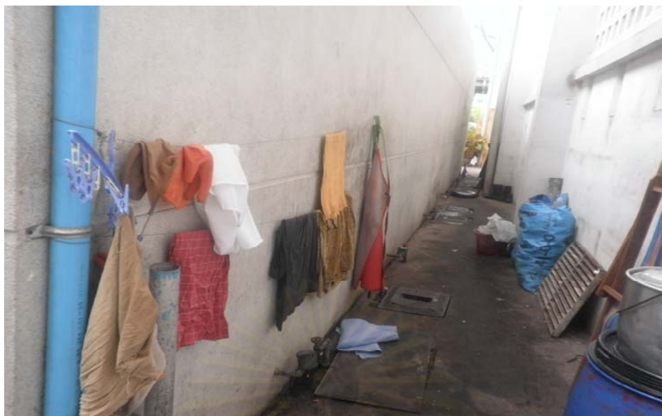
รูปภาพ 4.30 สภาพบริเวณด้านหลังโรงอาหารรวมอาคารจุฬาพัฒนา 9
