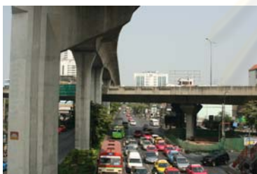
มุมมองจากทางเท้ายกระดับอนุสาวรีย์
