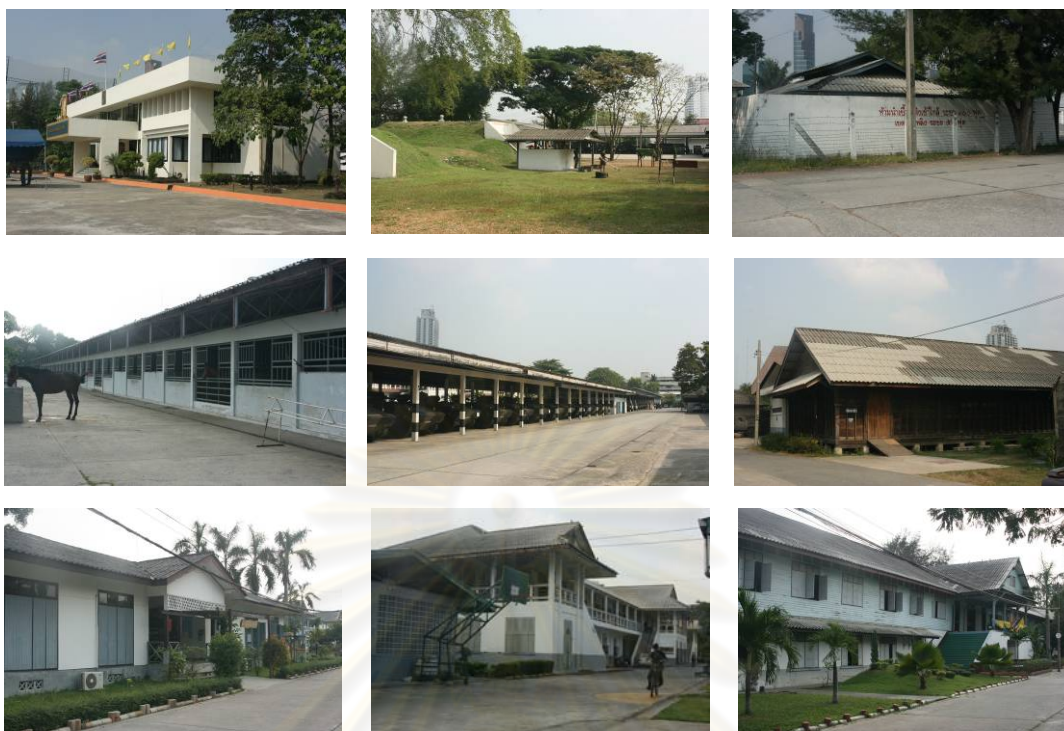
ภาพที่ 4.43 ลักษณะทางด้านรูปแบบ-วัสดุอาคารส่วนสำนักงาน
