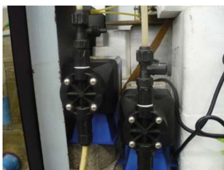
รูปที่ 3.2 เครื่องสูบน้ำ (ก) แบบไดอะแฟรม (ข) แบบปริดสาย
