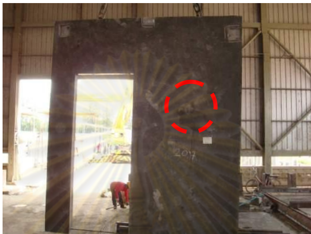
รูปที่ 3.28 ลักษณะ Quick Tapping ไม่ตรงตำแหน่ง
