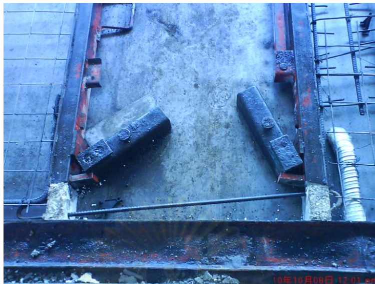
รูปที่ ข.5 ลักษณะการวางแม่เหล็กที่ไม่เหมาะสม
