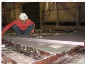
รูปที่ 1.12 การเกลี่ยและขัดผิวหน้าคอนกรีต
