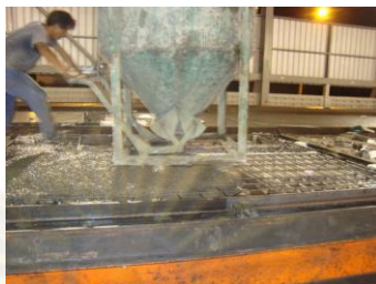
รูปที่ 1.11 การเทคอนกรีต
