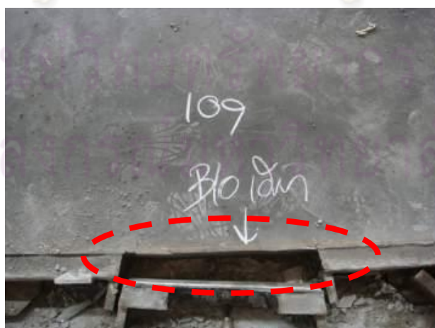
รูปที่ 3.23 ลักษณะ Block Out เคียง
