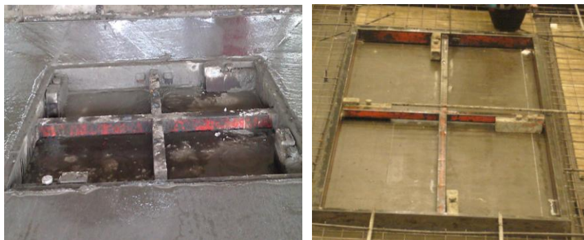
รูปที่ 6.4 ลักษณะการติดแม่เหล็กที่เหมาะสมขึ้น
