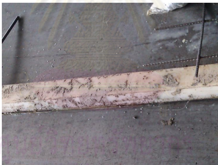
รูปที่ ข.2 สภาพ Key Joint ที่ไม่สะอาด
