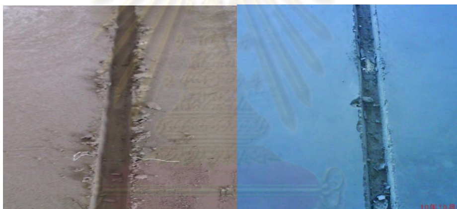
รูปที่ ข.6 ลักษณะการถอด Key Joint ที่ไม่มีมาตรฐาน
