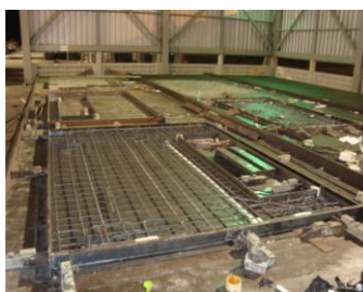
รูปที่ 1.10 ติดตั้งวัสดุฝังและวางโครงเหล็กเสริม
